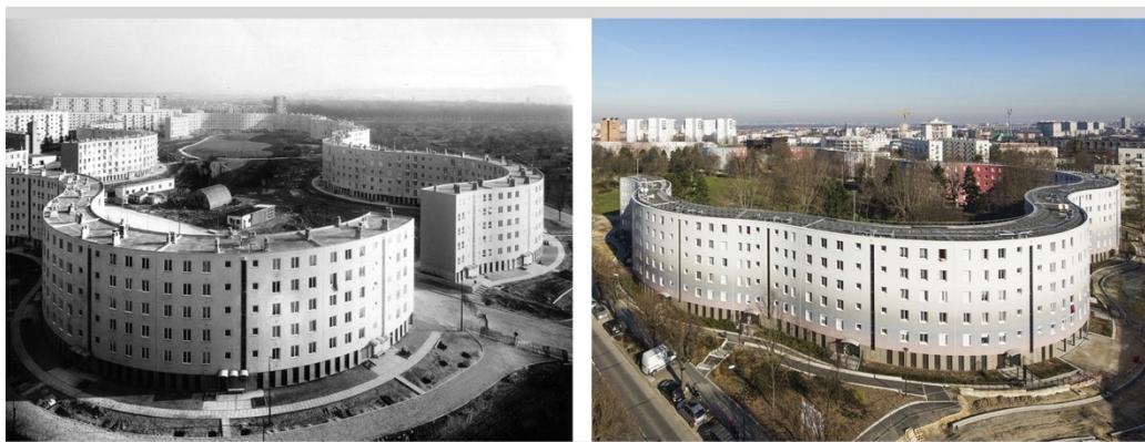
Fig. 5.25 Reabilitarea termică a unui complex de locuințe colective: Le Serpentin, Pantin, Franța – situația existentă vs. situația după reabilitare
