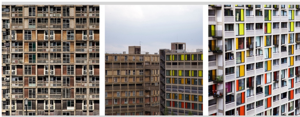
Fig. 5.7 Reabilitarea complexului de locuințe sociale Park Hill Estate, Sheffield, Marea Britanie – situația inițială vs. situația după reabilitare
