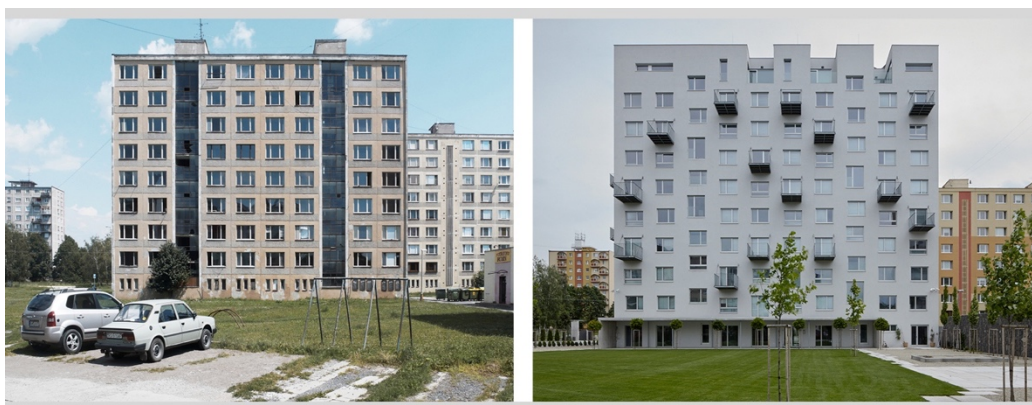
Fig. 5.6 Reabilitarea fațadelor prin reconfigurarea acestora ca urmare a recompartimentării spațiului interior: Rimavska Sobota, Slovacia – situația inițială vs. situația după reabilitare
