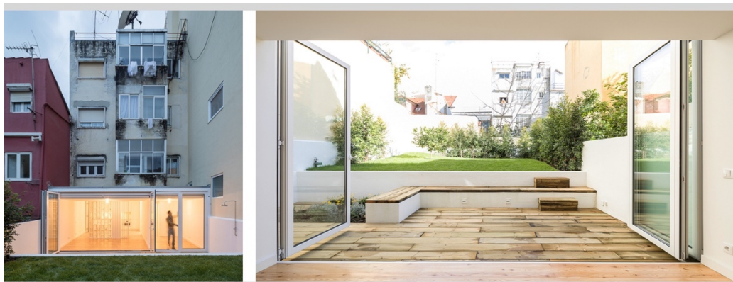
Fig. 5.24 Îmbunătățirea suprafețelor și dotărilor apartamentelor existente prin extinderea suprafeței utile: Sao Felix, Lapa, Portugalia - volumul adosat clădirii existente și vedere din interior
