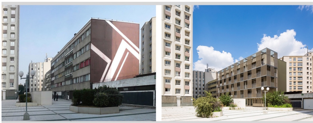
Fig. 5.5 Reabilitarea fațadelor prin „îmbrăcarea” clădirii cu o nouă coajă: Piața Vitruviu, Paris, Franța – situația inițială vs. situația după reabilitare
