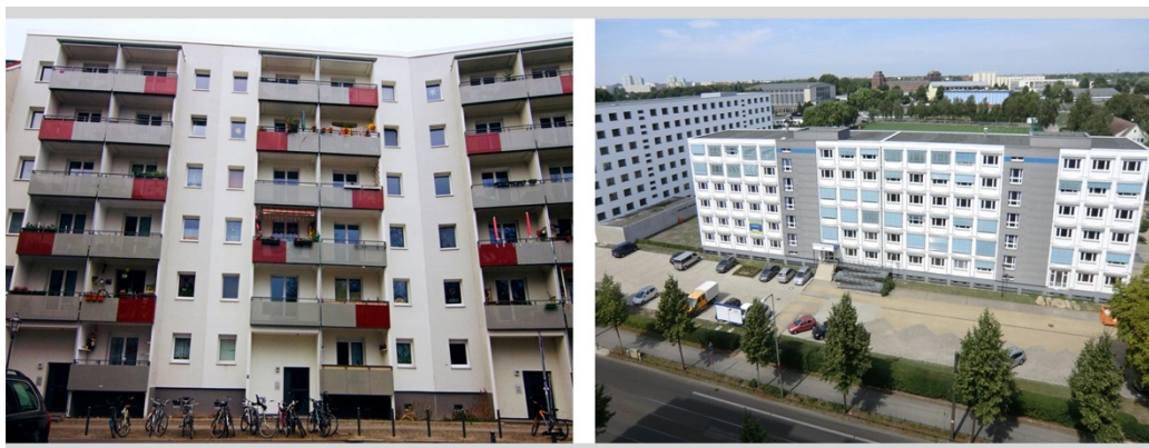
Fig. 5.4 Reabilitarea fațadelor prin înlocuirea finisajelor existente cu termosistem: Konrad-Wolf Strasse 45/46 și Linienstrasse-Mitte, Berlin, Germania
