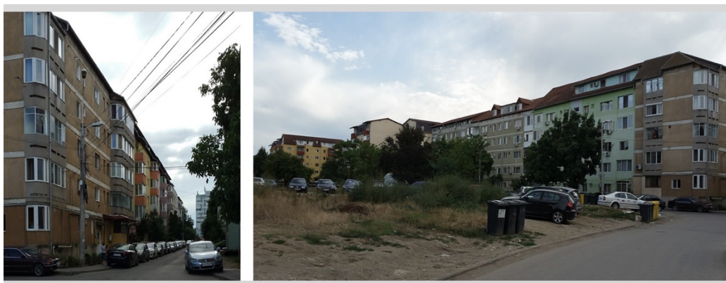
Fig. 5.2 Cartierul Timișoara Sud: clădiri reabilitate termic, a căror imagine nu este coordonată la nivelul cartierului
