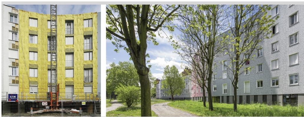
Fig. 5.26 Reabilitarea termică a unui complex de locuințe colective: Le Serpentin, Pantin, Franța – imagine din timpul reabilitării și perspectivă asupra ansamblului rezultat
