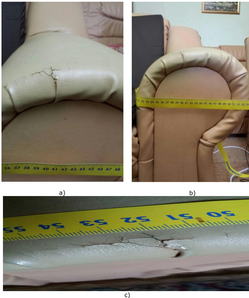
Fig. 2.16. Imagini cu zone degradate de tapițerii: a) imagine degradare pliu cotieră fotoliu, b) vedere de ansamblu cu cotiera degradată, c) imagine mărită pliu degradat.
