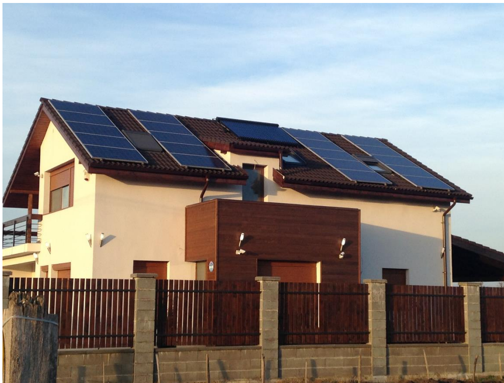
Fig.4.15. Exemplu de montare a panourilor solare
