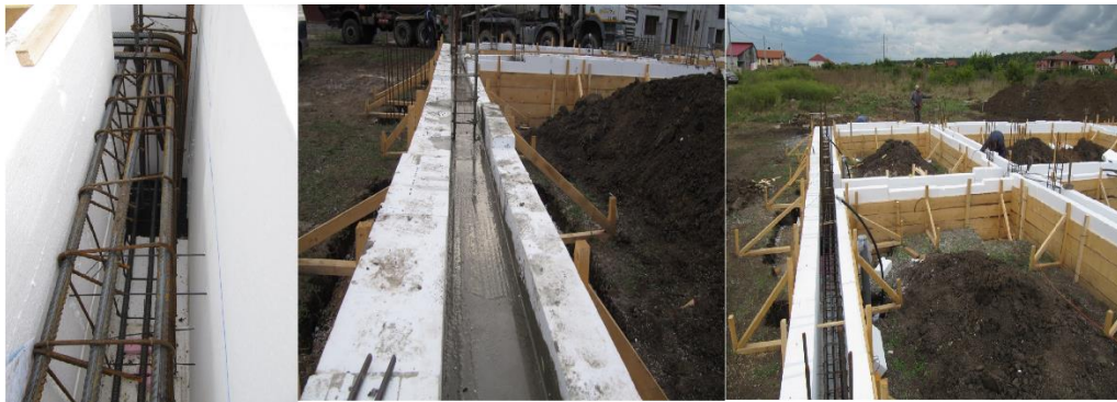
Fig.4.6. Termoizolarea zonei de fundații sursa[29]
