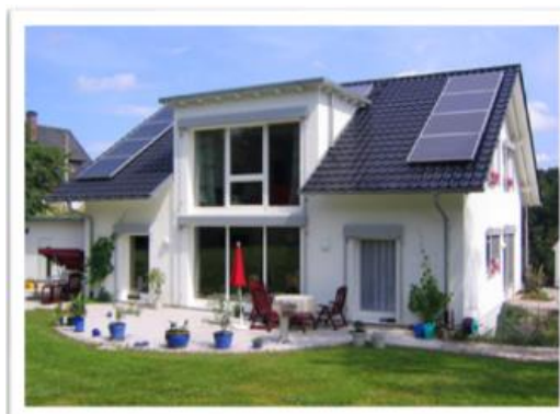
Fig.3.1. Casă pasivă, ID 0806 sursa[34]
