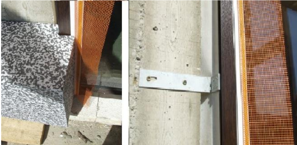
Fig.4.9. Exemplu montare ferestre
