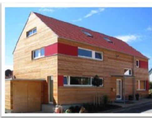
Fig.3.2. Casă pasivă, ID 0406 sursa[34]
