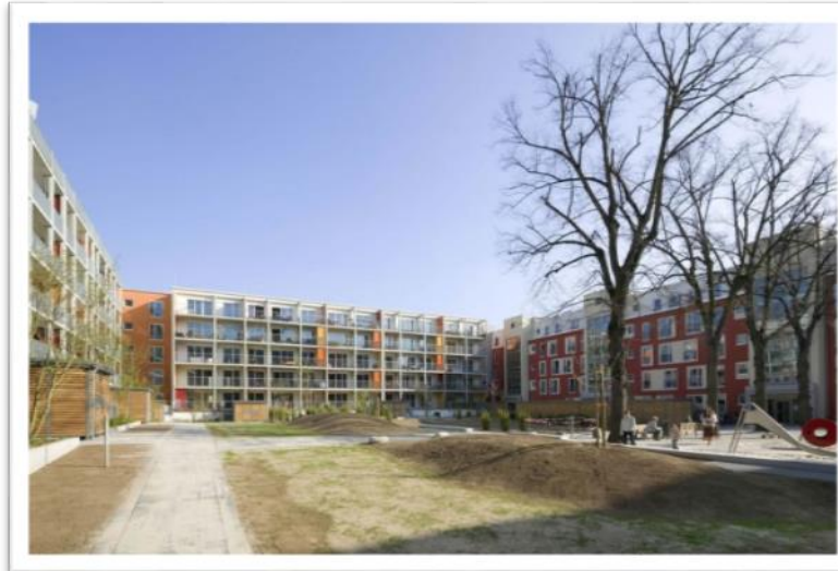
Fig.3.4. Clădire multietajată, Frankfurt, Germania, ID 0882 sursa[34]
