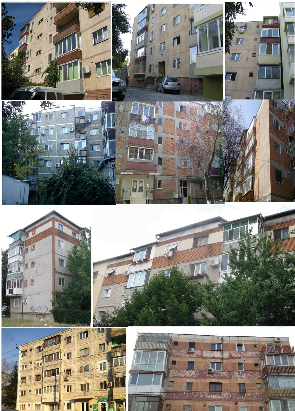
Fig.5.29. Clădirile cu structură de rezistență din panouri mari prefabricate din beton armat cu 5 niveluri analizate
