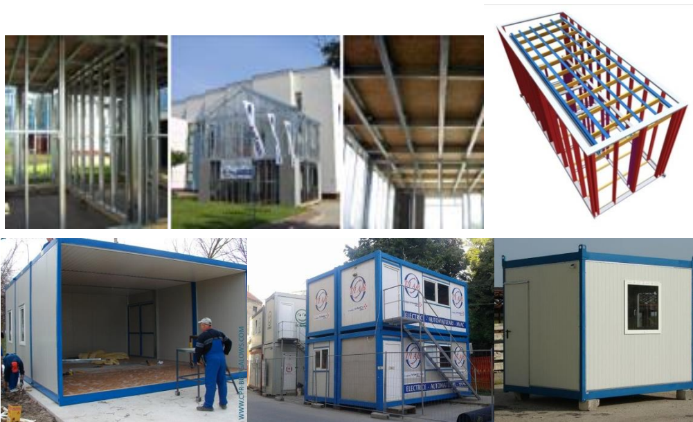
Fig. 4.31. Exemple întâlnite în practica de structuri modulare
