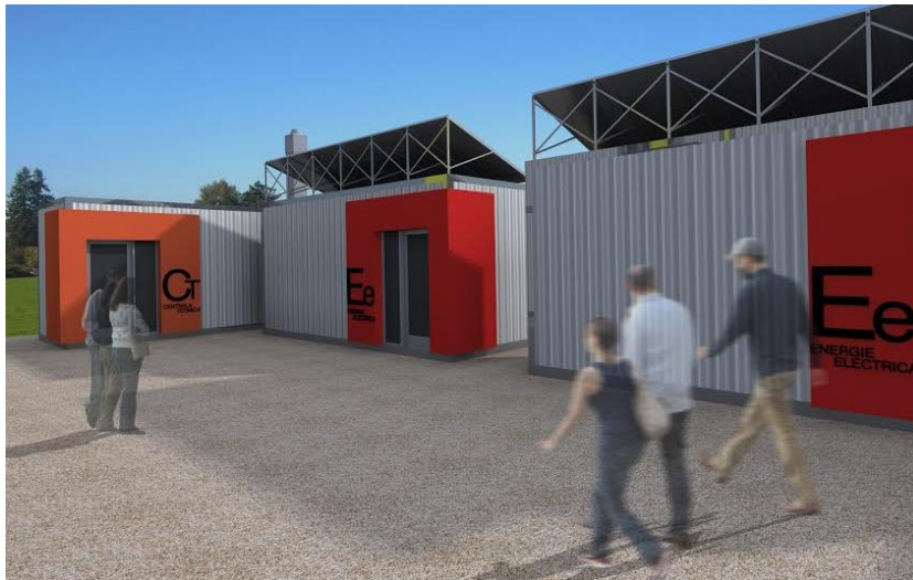
Fig. 4.13. Exemplu de unitate modulară prevăzută cu panou fotovoltaic, folosită pentru obținerea energiei regenerabile
