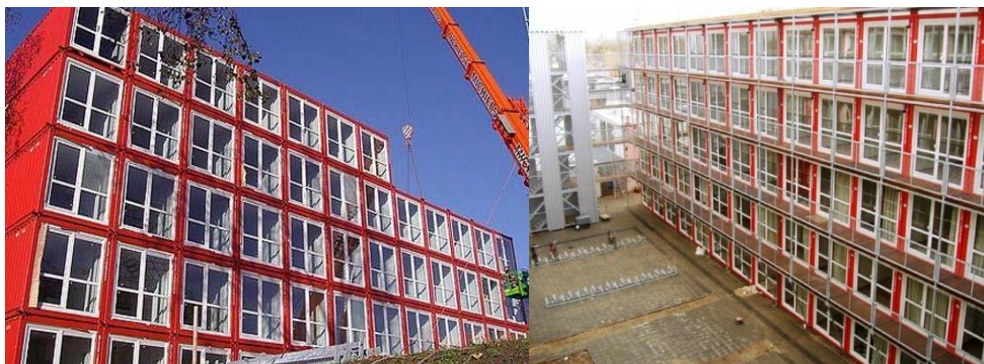
Fig. 2.11. Complex de dormitoare pentru studenți , Tempohousing Keetwonen Student Housing, Amsterdam
