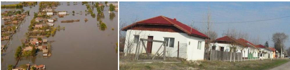
Fig. 3.7. Satul Otelec, în timpul inundațiilor și după inundații
