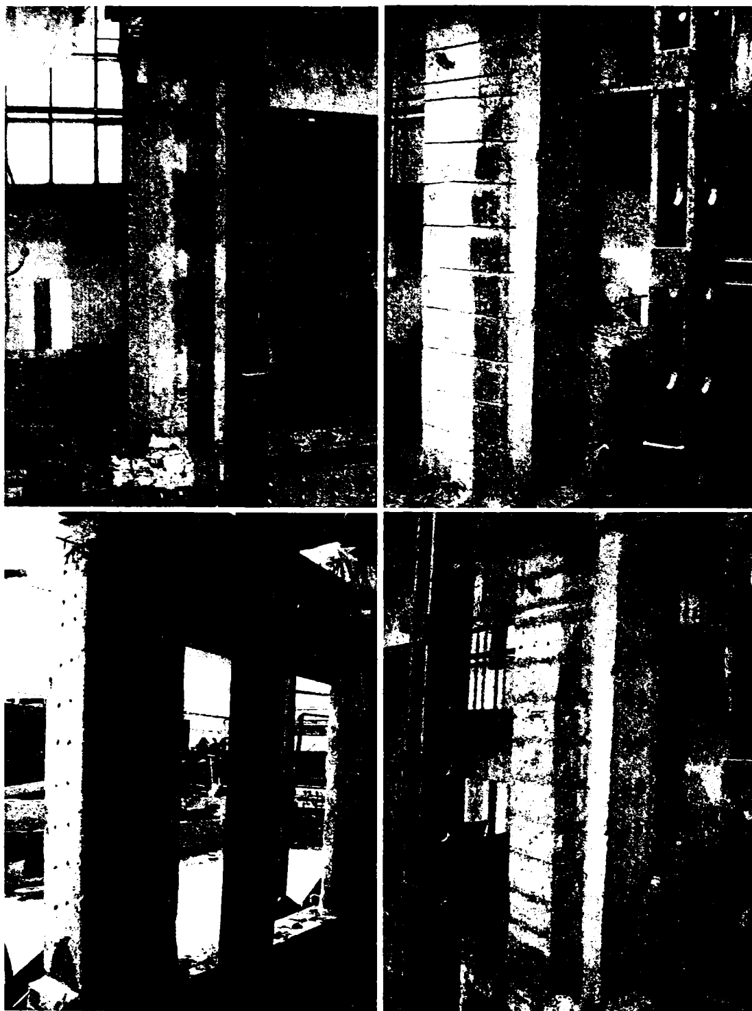
Figura 2.33 (continuare) – Detalii de consolidare FRP
