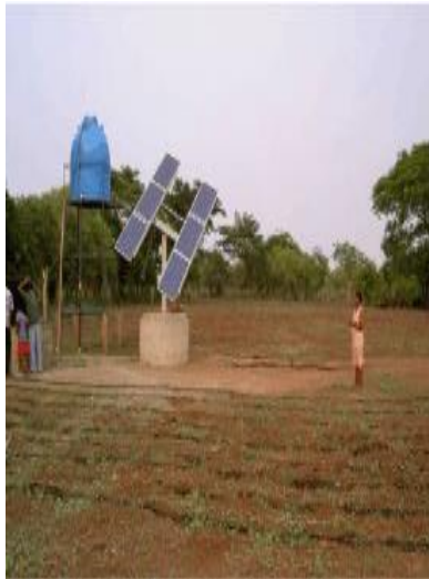
Fig.3.8. Sistem pompare adâncime PS4000 31 mc/zi de la 160m (țara: Turcia): a) vedere ansamblu frontal ; b) canal irigații.
