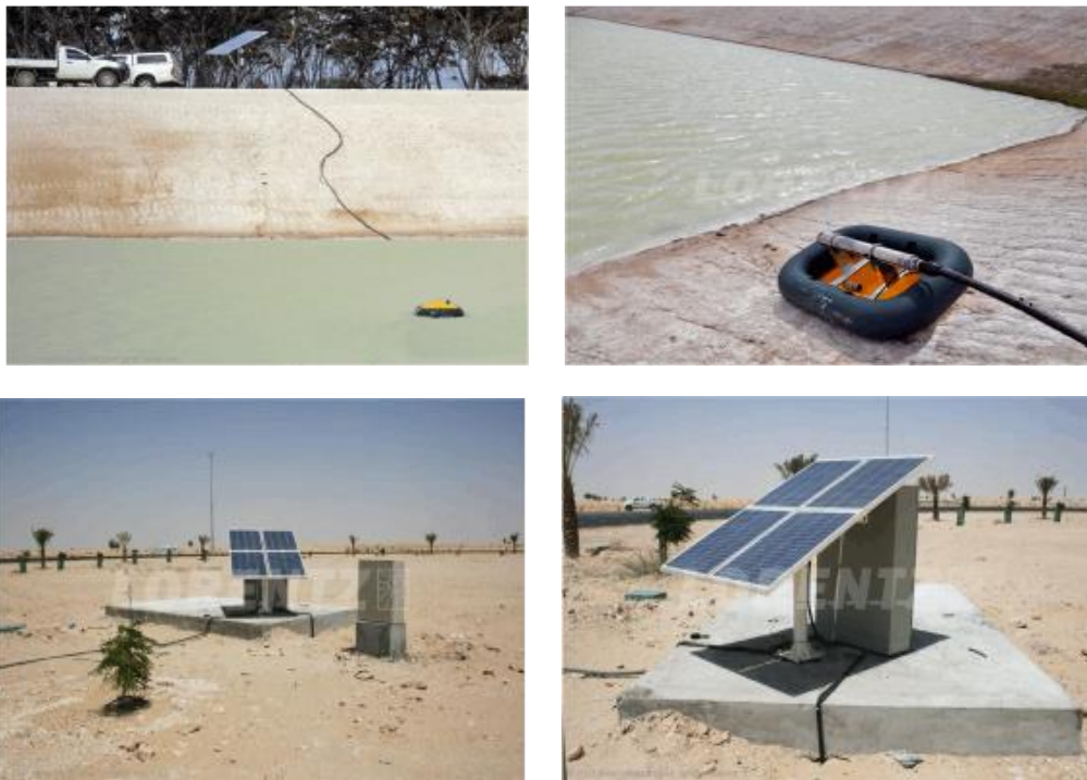
Fig. 3.10. Sistem pompare adâncime PS200(țara: Emiratele Arabe).
