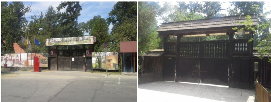
Fig. 6.26 Imagini cu situația existentă a porții de acces în incinta Muzeului Banatului, Timișoara
