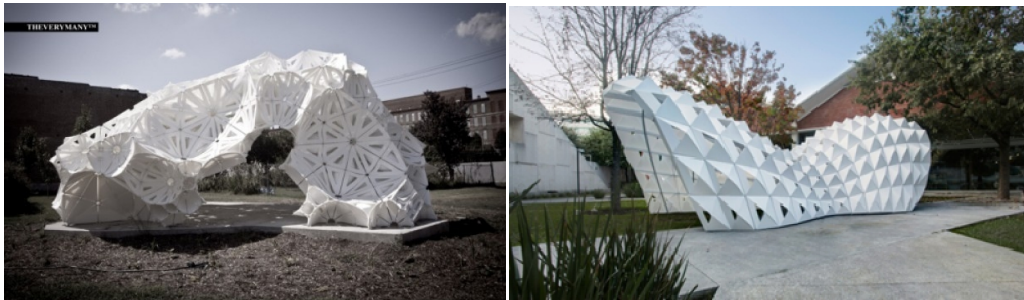
Fig. 4.31 (a) Pavilionul Plasti(k) - arh. Marc Fornes & The Verymany, St.Louis, USA, 2011 128 ; (b) Pavilion parametric - arh. Escuela de Arquitectura, Arte y Diseño del Tecnológico, Monterrey, Mexic, 2015 129
