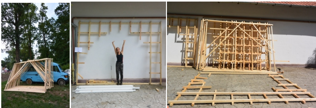
Fig. 6.40 Imagini cu cadrele transversale construite izolat
