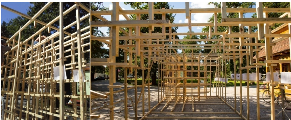
Fig. 6.42 Imagini din timpul procesului de asamblare a cadrelor de lemn
