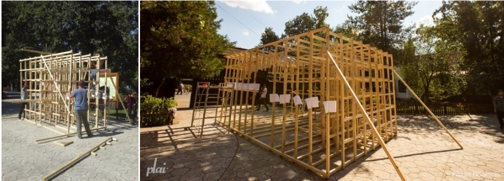
Fig. 6.41 Imagini din timpul procesului de asamblare a cadrelor de lemn
