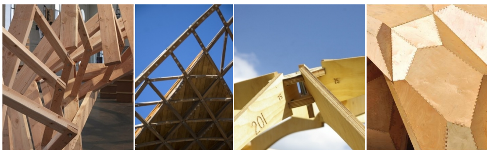
Fig. 5.6 Variante de îmbinări ale elementelor din lemn (a) chertări; (b) fixare cu piese metalice (c) piese de îmbinare din lemn; (d) operații dulgherești de îmbinări multiple
