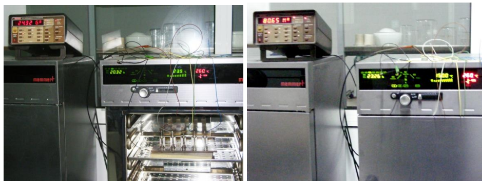
Figura 5.4.- Stand de măsurare a variației rezistenței electrice cu temperatura.
