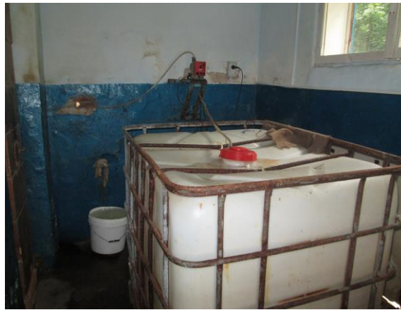
Fig. 31 Stația de tratare a apei Anina
