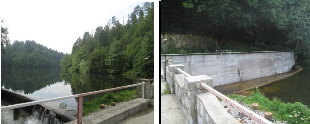
Fig. 43 Lacul Buhui-zona deversorului
