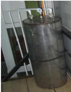
Figura 4.2.3.- Rezervor stocare biogaz [94]
