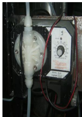
Figura 4.3.3. Pompă dozatoare spălător pentru spălarea [94]
