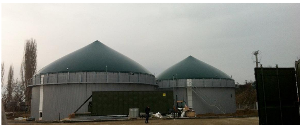
Figura 3.2.1. Instalația de biogaz de la Filipeștii de Pădure, jud. Prahova,[37]
