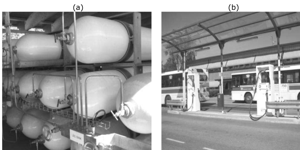
Figura 3.6.2.2. (a) Rezervoare de stocare biogaz și (b) stațiile de alimentare cu biogaz. [57]
