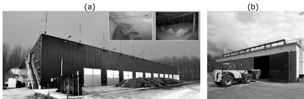
Figura 3.5.4. (a) Vederea frontală a instalației de biogaz cu digestie uscată din Gorizia (Italia) adaptată [89], (b) procesul de încărcare a reactorului cu digestie uscată
