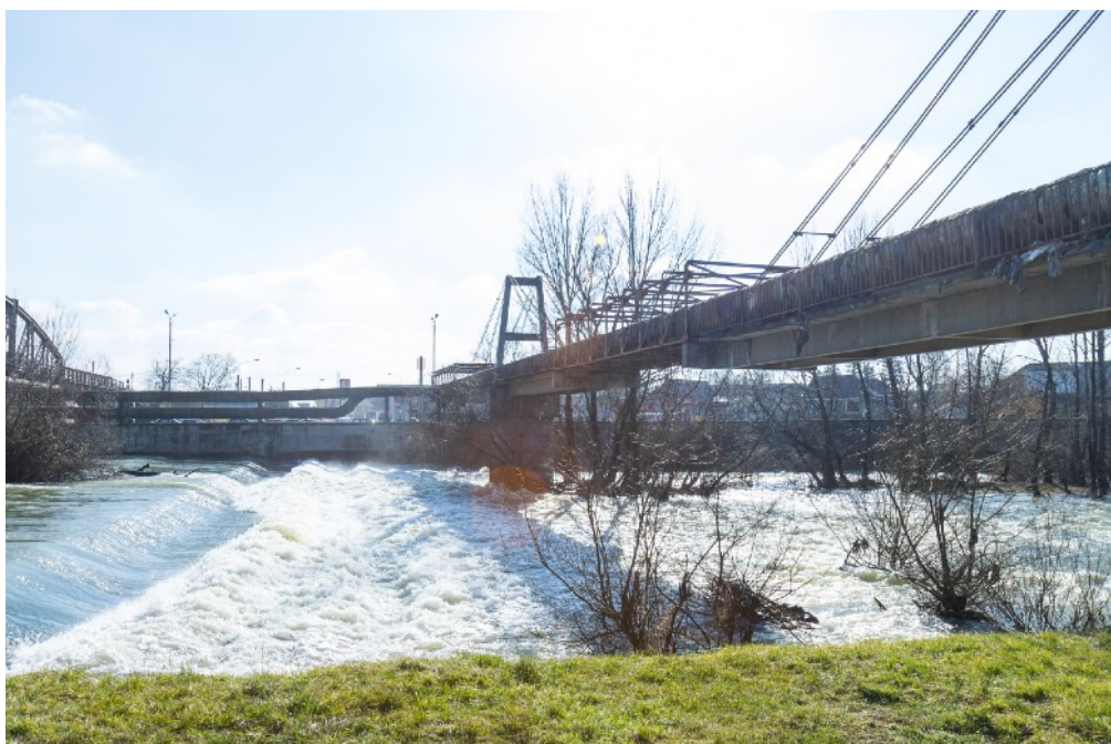
Supratraversare a conductelor de termoficare - Oradea, jud. Bihor
