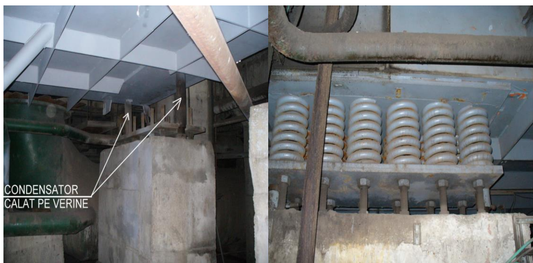
Fig. 2.8. Așezarea condensatorului de abur pe fundație.
