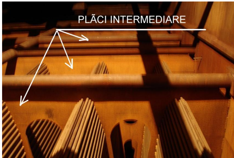
Fig. 2.9. Plăcile tubulare intermediare din racordul de abur.
