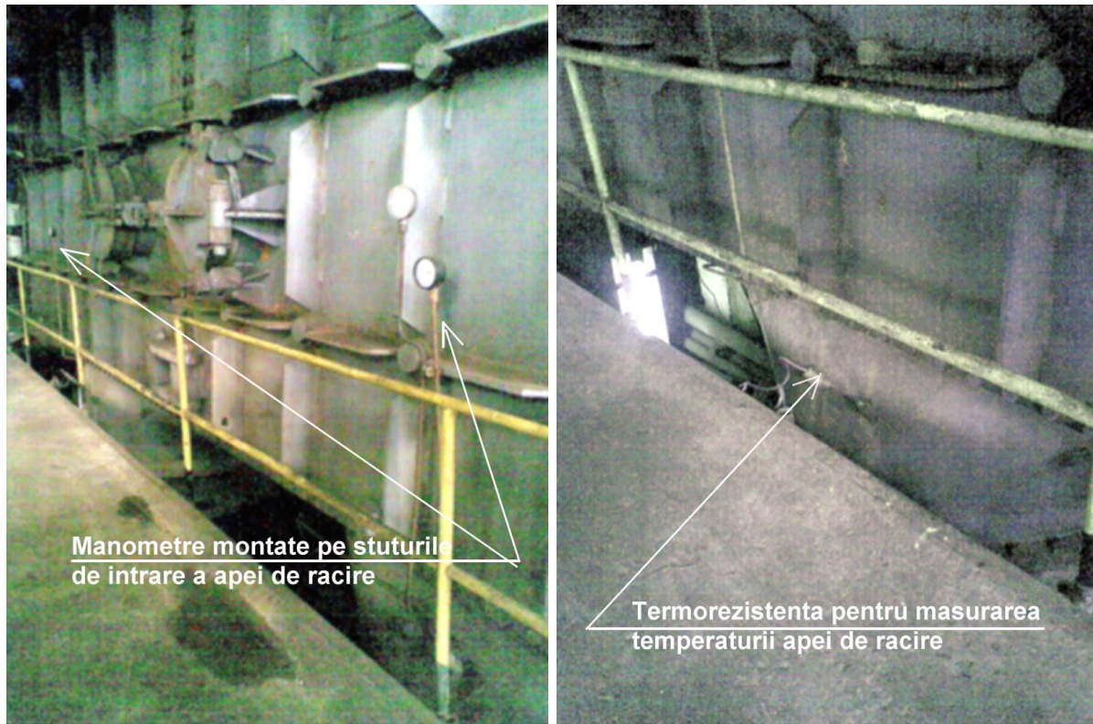
Fig. 4.4. Amplasarea aparatelor de măsurare a presiunii și temperaturii la intrarea apei de răcire în condensatorul de abur.
