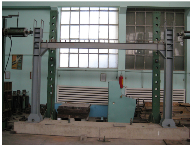
MONTARE ȘI SUDURĂ CADRU METALIC
