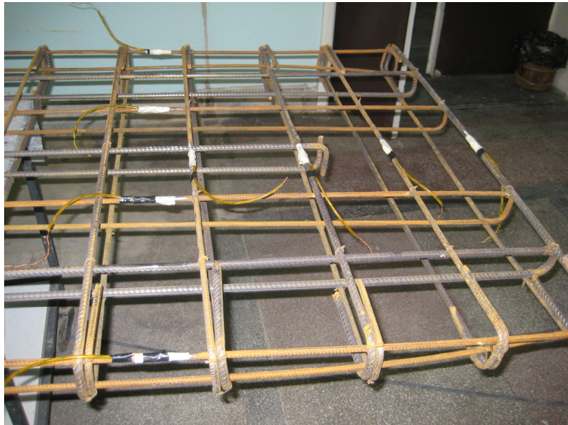
CONFEȚIONARE CARCASĂ ARMĂTURĂ ȘI MONTAJ TIMBRE PE CARCASĂ
