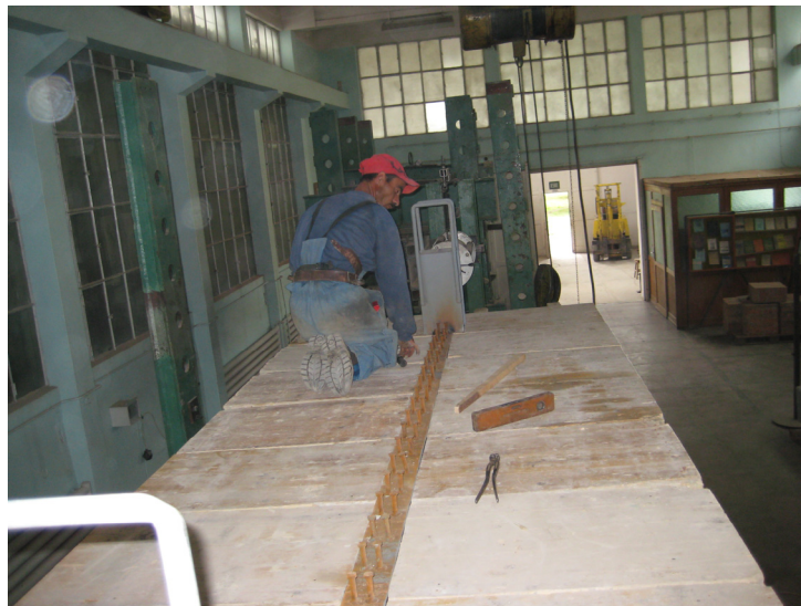
POZIȚIONARE COFRAJ LA FAȚA SUPERIOARĂ A GRINZII
