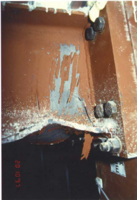
a. Flambajul grinzii la talpa inferioară
