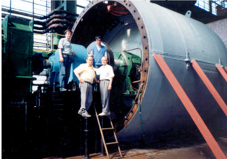
Figura 4.26. Hidrogeneratorul reversibil de 13880 kVA (Slatina Aval) pregătit pentru teste de pornire în regim asincron în standul de probe.
