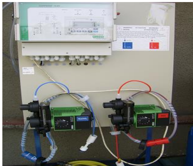
Figura 7.3. Imaginea sistemului automat de preparare a \text{ClO}_2 .
