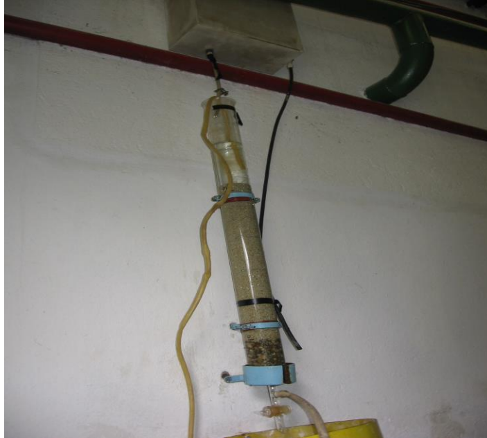
Figura 10 2. Imaginea instalației de filtrare a apei decantate.
