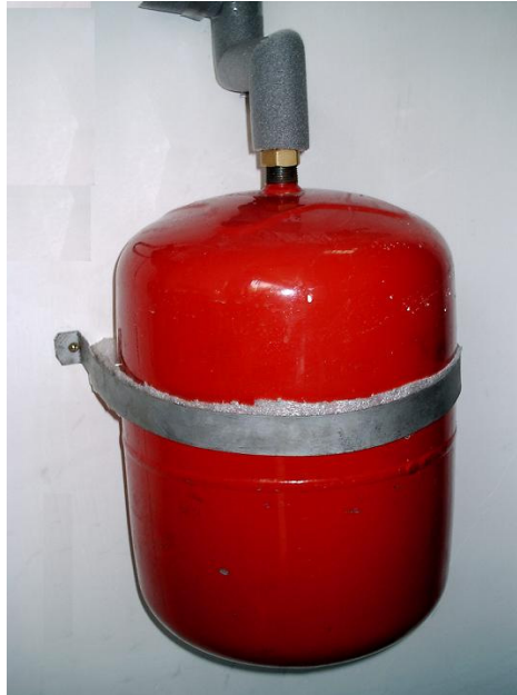
Fig. 4.18. Vas de expansiune.
