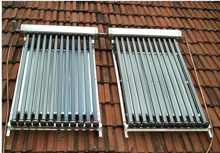
Fig. 4.8. Panouri solare, montate pe acoperiș (faza intermediară).
