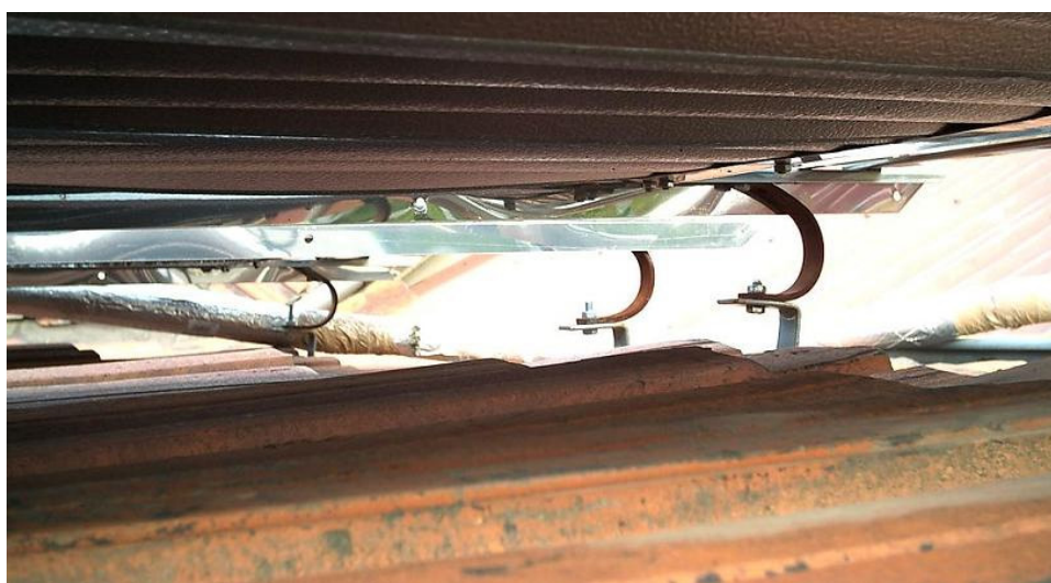
Fig. 4.5. Sistem de prindere al suportului pe acoperiș.
