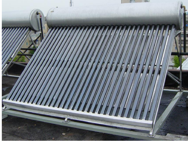
Fig. 3.3. Captatoare solare cu tuburi vidate [*****18].
