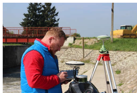
Fig. 4.44 Inițializarea Statică a rucsacului în vederea scanării (Șmuleac A., 2019)
