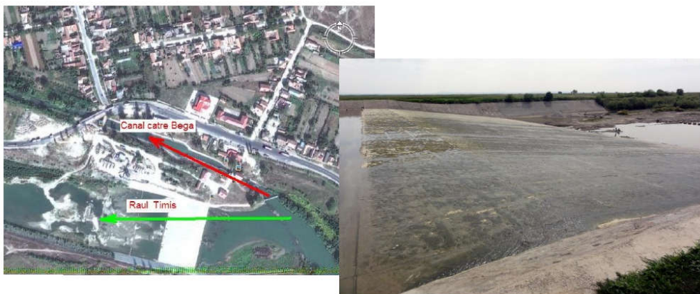
Fig. 3.3 Nodul hidrotehnic Coșteiu dintre râul Timiș și canalul Bega Vedere aeriană (sus) și pragul deversor din cadrul nodului (jos) (Șmuleac A., 2018)
