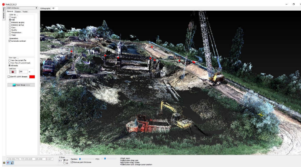
Fig. 4.99 Renovarea Ecluzei din Sânmihaiu Roman, scanare realizata la date de 23.07.2019 (Șmuleac A., 2019)
