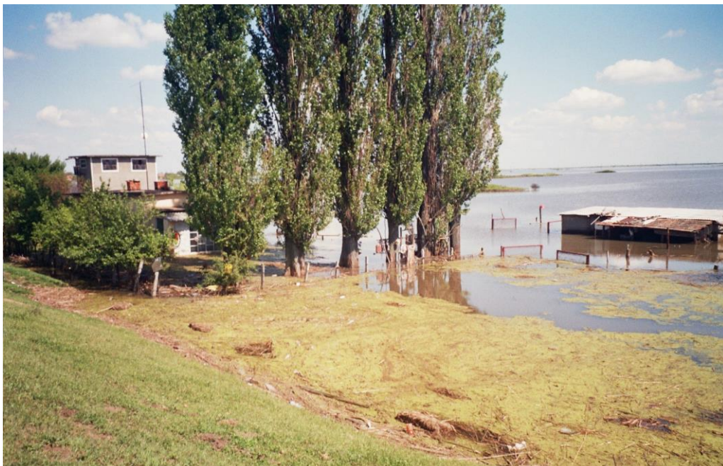
Stația de pompare Otelec – mal stâng Canal Bega
