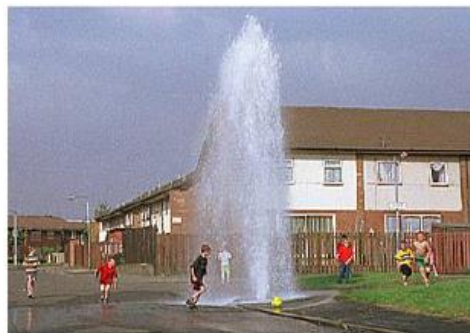
Figura 3. 35 Spargeri de conducte
