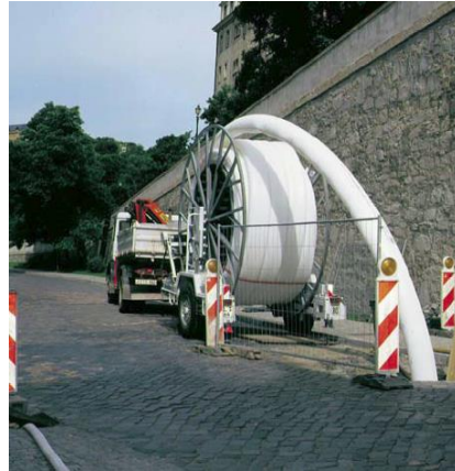
Figura 4.6 Utilaj pentru realizarea cămășuirii conductelor
