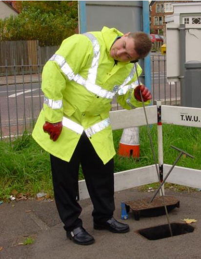
Figura 3. 25 Ascultarea unui hidrant subteran
