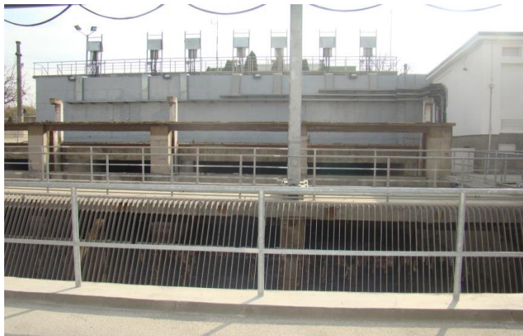
Fig. 4.2.3 - Gratarul mecanic la intrarea în SE Timișoara
