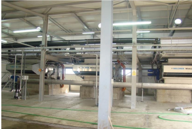
Fig. 4.2.9 - Prese Bellmer SE Timișoara
