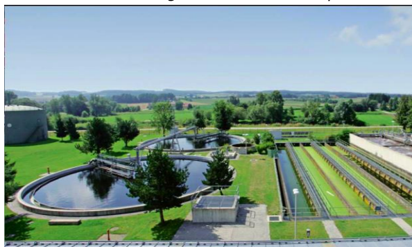
Fig. 4.1.1 S Stația de epurare A
