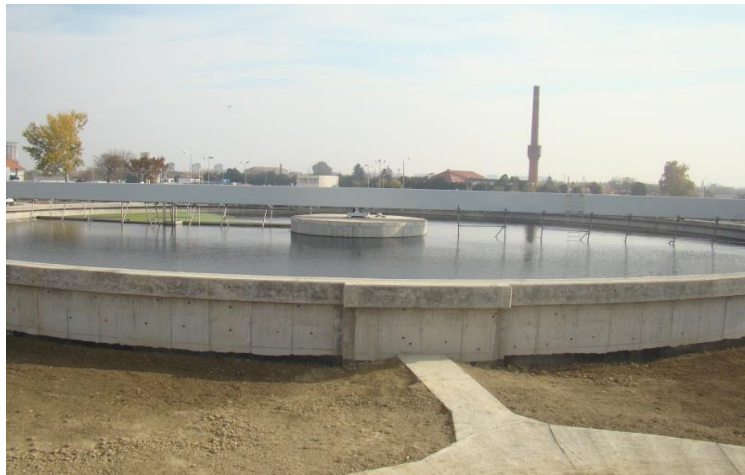
Fig. 4.2.7 - Decantor secundar SE Timisoara
