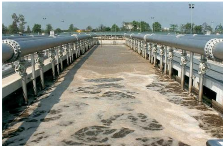
Fig. 4.3.4 – Bazin de activare
