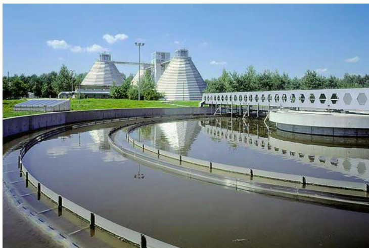
Fig. 4.3.5 – Bazin de decantare scundară
