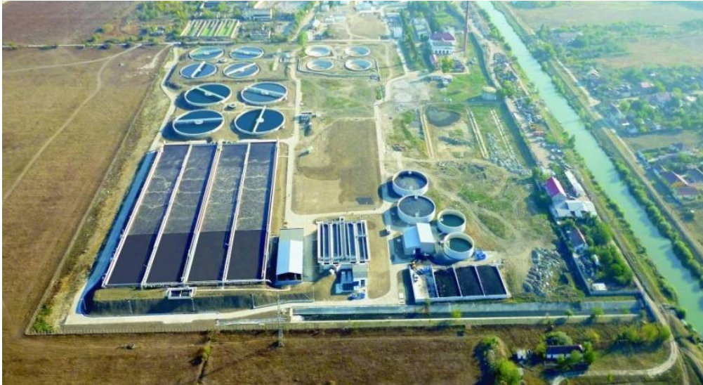
Fig. 4.2.1 Stația de epurare Timișoara
