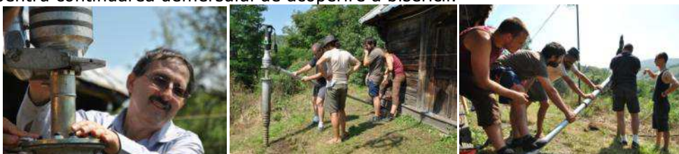
Fig. 10 –Testarea introducerii a două fundații metalice tip Krinner . Foto echipa Biserici Înlemnite 2014
