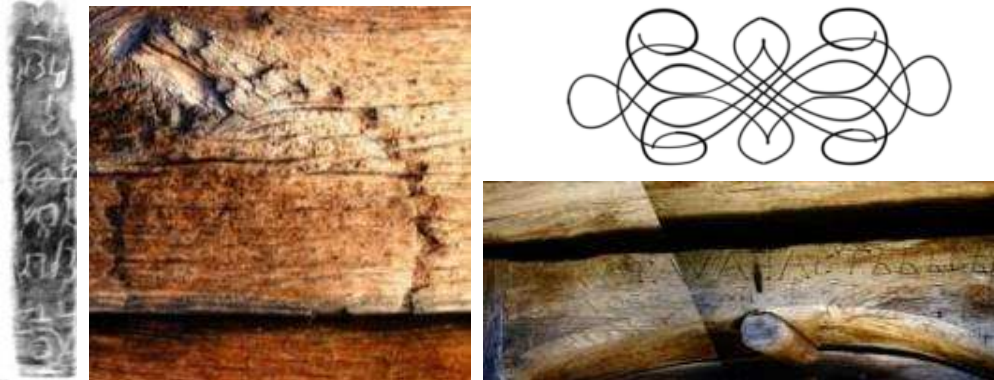
Fig. 41 – Exemple de urme găsite pe biserică: Stâlp funerar folosit ca montant al timpanului de vest al bolţii peste naos /Simbol solar la piciorul portalului sudic /Parte dintr-un simbol al infinitului (posibil un simbol nobiliar) /Pisania de pe portalul sudic. Foto Echipa Biserici Înlemnite
