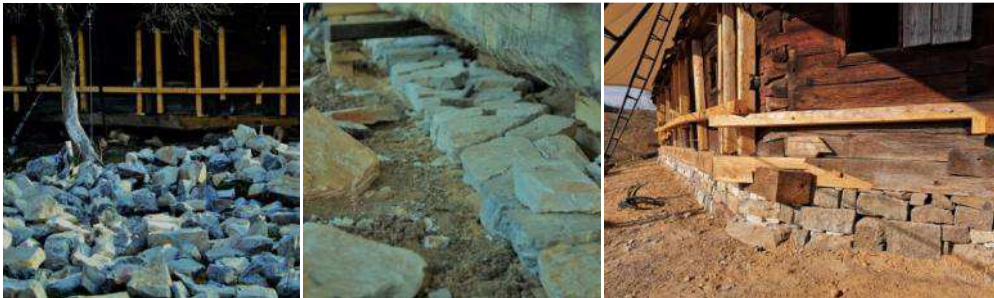
Fig. 26 – Imagini din timpul zidirii fundațiilor de piatră. Foto echipa Biserici Înlemnite, iul.2018
