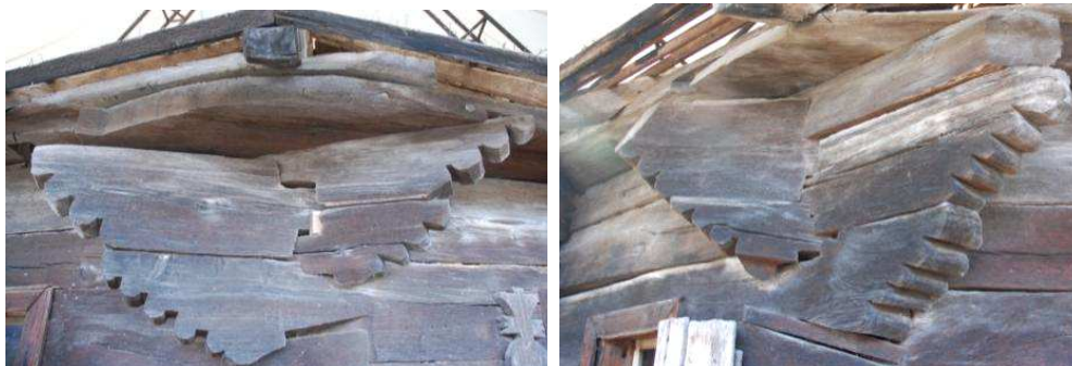
exemplu de console (aripi) : colțul: dintre a-NE și a-SE (stânga) dintre a-SE și a-SSE (dreapta)
