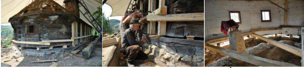
Fig. 25 – Imagini din timpul ridicării bisericii. Foto echipa Biserici Înlemnite, iul.2018
