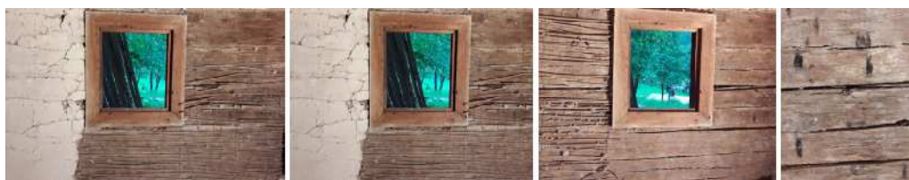
Fig. 68 – Cuie industriale speciale folosite în perioada interbelică, pentru prinderea sârmei ce fixează trestia, suportul pentru tencuiala de var. Foto echipa Biserici Înlemnite 2019
