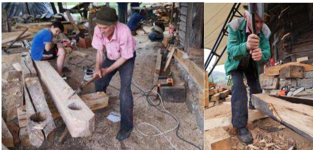
Fig. 61 –Meșterul Nicolae Toader refăcând din bardă și secure, după modelul original, una din grinzile superioare ale turnului degradate / Meșterul Nicolae Toader prelucrând în bardă un element pentru continuizare. Foto echipa Biserici Înlemnite 2019
