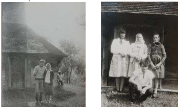
Fig. 52 – Imagini găsite cu ocazia interviurilor din cadrul studiilor antropologice, iul.2016 În fotografii se pot observa finisajele din perioada realizării acestora precum și faptul că pereții erau mai puțin deformați la partea superioară ca înaintea conservării.
