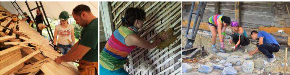
Fig. 27 – arh. Eugen Vaida și voluntarii Ambulanței pentru Monumente Banat la montarea șindrilei / tencuirea cu pământ din timpul atelierului de vară / montajul pavajului de piatră din timpul atelierului de vară. Foto echipa Biserici Înlemnite, iun.-iul.2019
