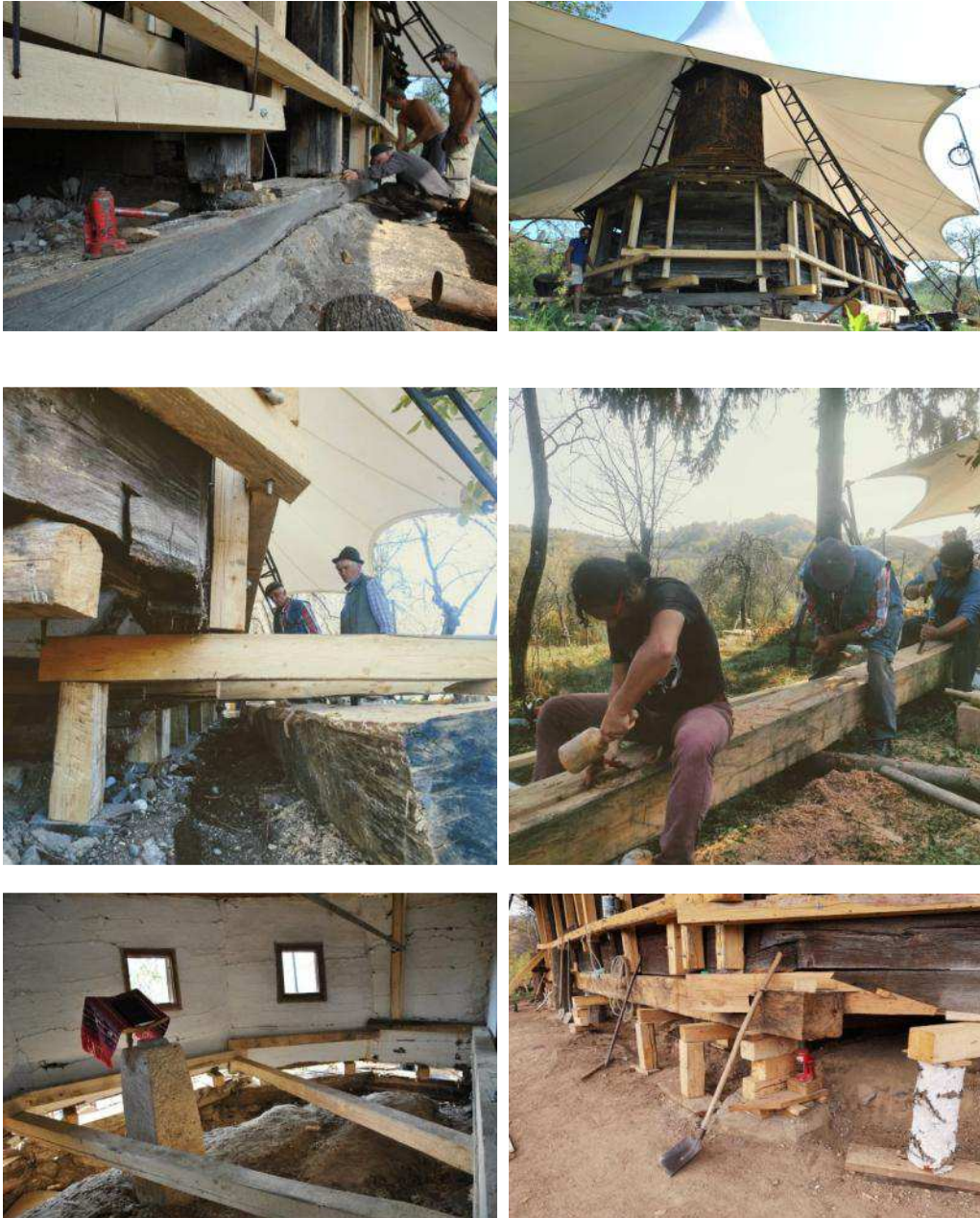
Fig. 79 –Biserica desprinsă de veche talpă / Biserica suspendată / Noua talpă este apropiată de biserică / Meșterii cioplesc golurile grinzii talpă transversală, în care vor intra limbile blănilor iconostasului / Vedere din altar cu biserica suspendată / Biserica suspendată cu noile tălpi montate pe poziție . Foto echipa Biserici Înlemnite 2019
