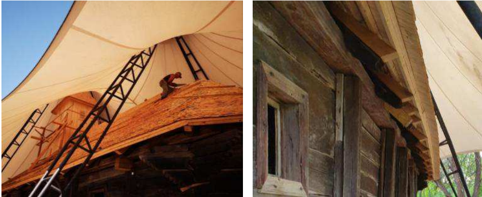
Fig. 62 – Detalii de streășină. Foto echipa Biserici Înlemnite 2019
