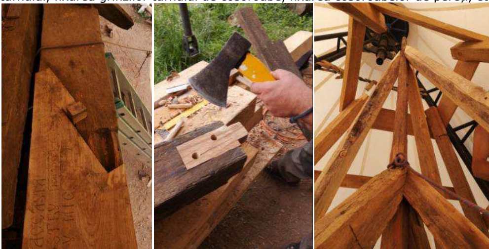
Fig. 83 –Continuizarea capătului sud vestic al cosoroabei sudice / Realizarea unui nou cep în locul celui degradat, la un cățel / Șarpanta refăcută a turnului. Foto echipa Biserici Înlemnite 2019
