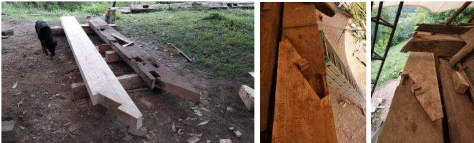
Fig. 56 – Elementul nou pentru continuare alături de porțiunea înlăturată / Îmbinarea de continuare de tip „gură de lup”. Foto Echipa Biserici Înlemnite
