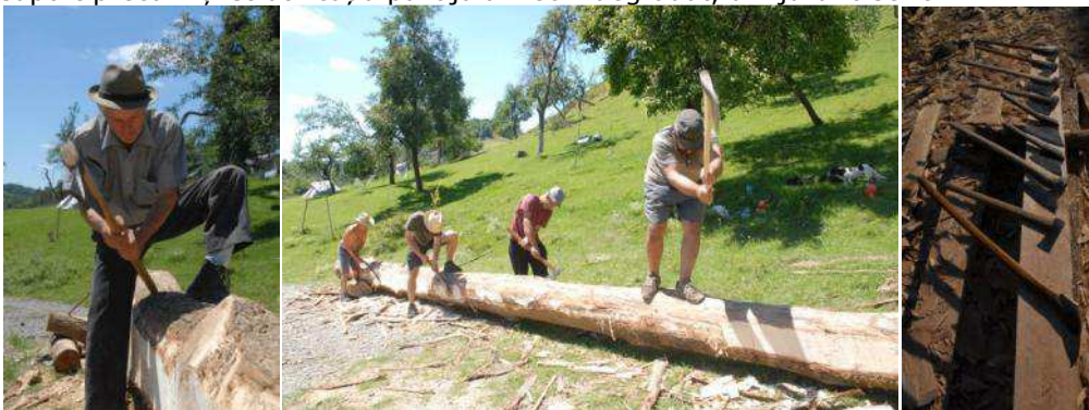
Fig. 24 – Imagini din timpul cioplirii tălpilor de gorun. Foto echipa Biserici Înlemnite, iul.2018
