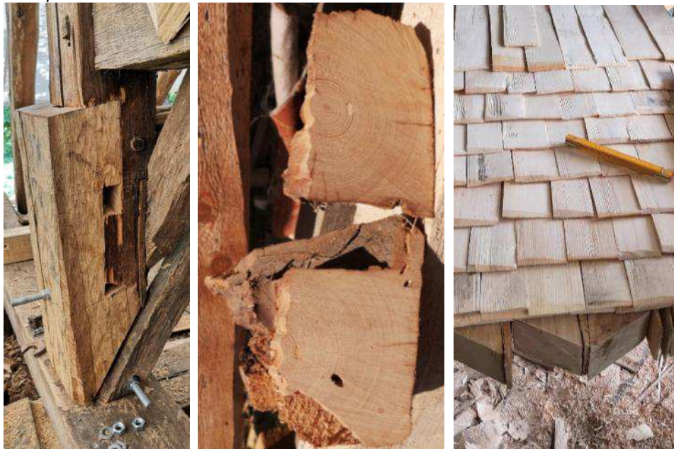
Fig. 80 –Continuizarea capătului inferior al stâlpului de nord-vest al turnului cu un element de stejar/ Porțiunea eliminată a stâlpului vechi, cu o densitate nemaivăzută a inelelor de creștere/ Dranița de dimensiuni scurte folosită la învelitoare bisericii . Foto echipa Biserici Înlemnite 2019
