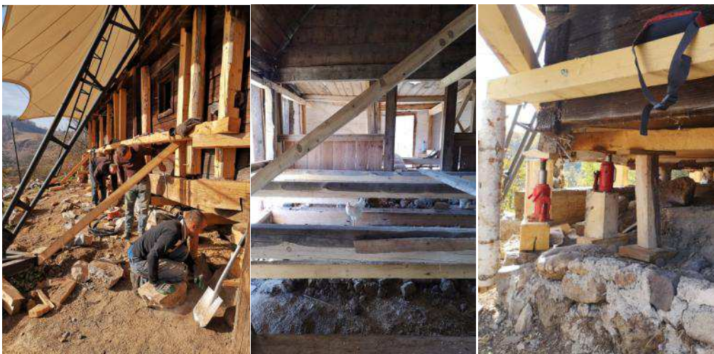
Fig. 81 – Eșafodajul de rezemare și ridicare a turnului / Schița de rigidizare a corpului bisericii și a bolții. Extras din proiectul tehnic realizat de către firma Irod M srl, ing. Dorottya Makay și echipa 2018
