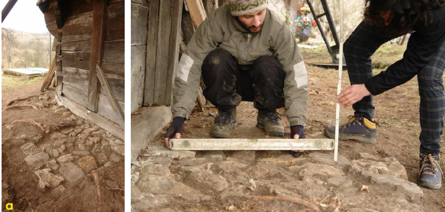
Primul sondaj din jurul bisericii, pavajul sub stratul vegetal și înclinația pavajului
