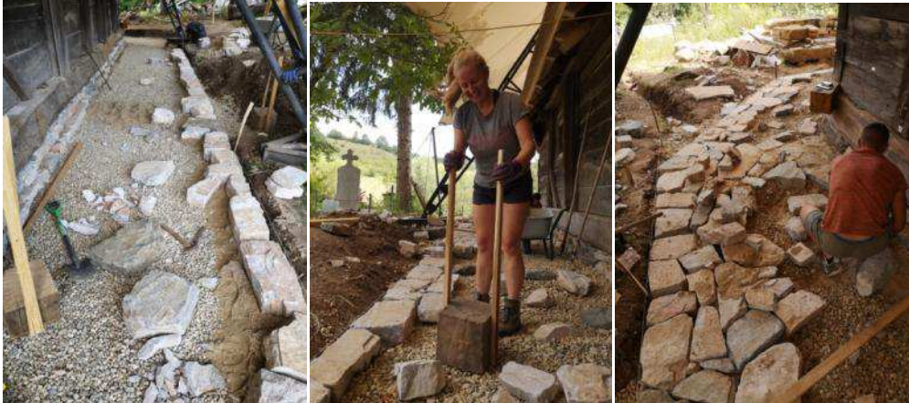
Fig. 85 –Etape din realizarea pavajului perimetral bisericii în timpul workshopului din vara anului 2019. Foto echipa Biserici Înlemnite
