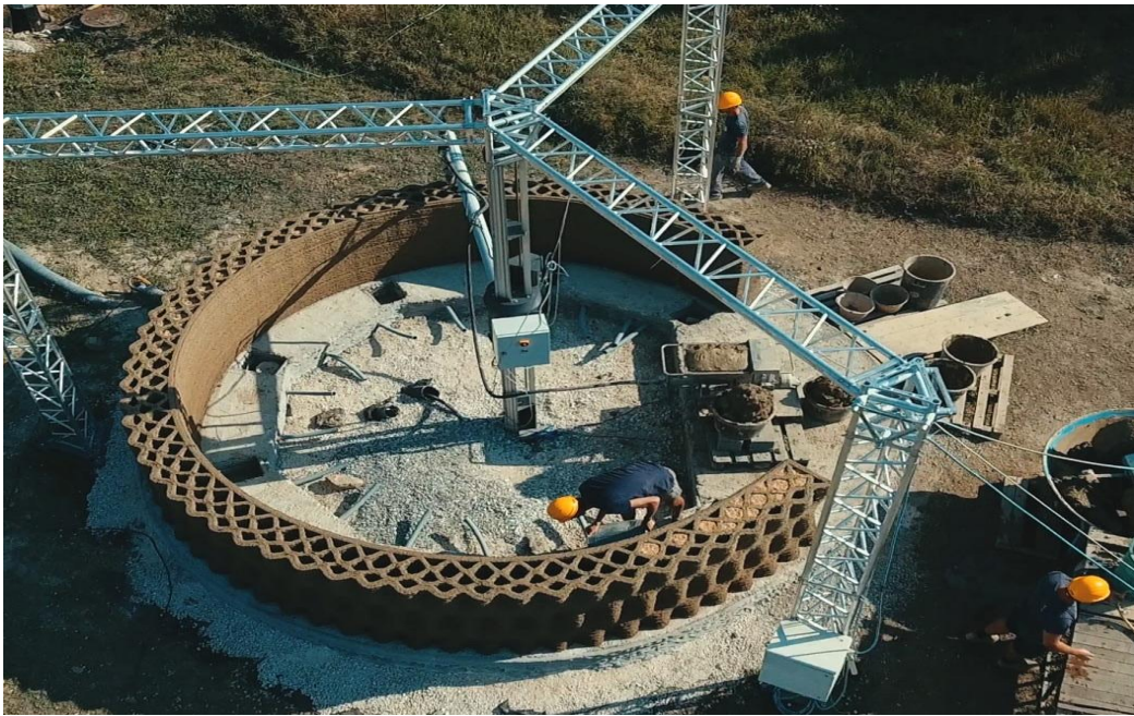
Fig. 71. Fotografie realizată în timpul imprimării 3D, preluare după: © https://www.3dwasp.com/en/3d-printed-house-gaia/ultima accesare: 01.2021;
