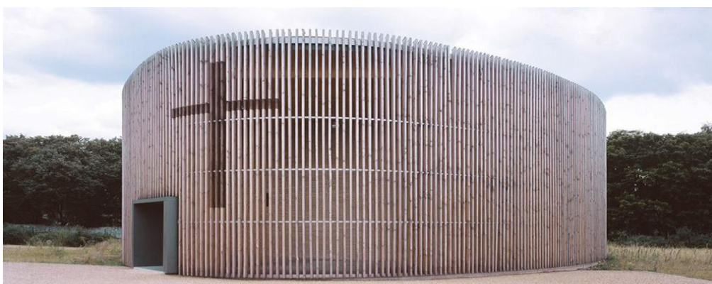
Fig. 44. Capela Reconcilierii, Berlin, arhitecții: Reitermann and Sassenroth, sursă: © pichleringenieure.com, ultima accesare: 01.2021;
