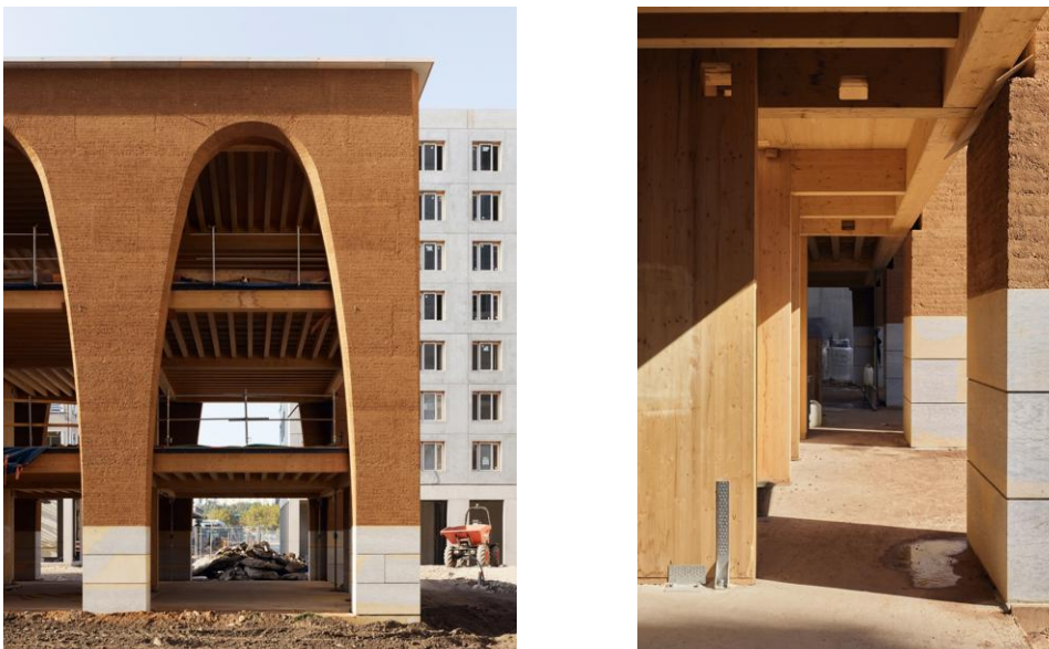
Fig. 242. Pavilionul Orangeriei în timpul construcției, sursă: F.Fouillet, preluat din articolul "L'Orangerie – A new generation of earth building in Lyon" de Stefan Jeske, Clément Vergély Architects (CVA), Lyon, France, publicat în cadrul conferinței Lehm 2020;
