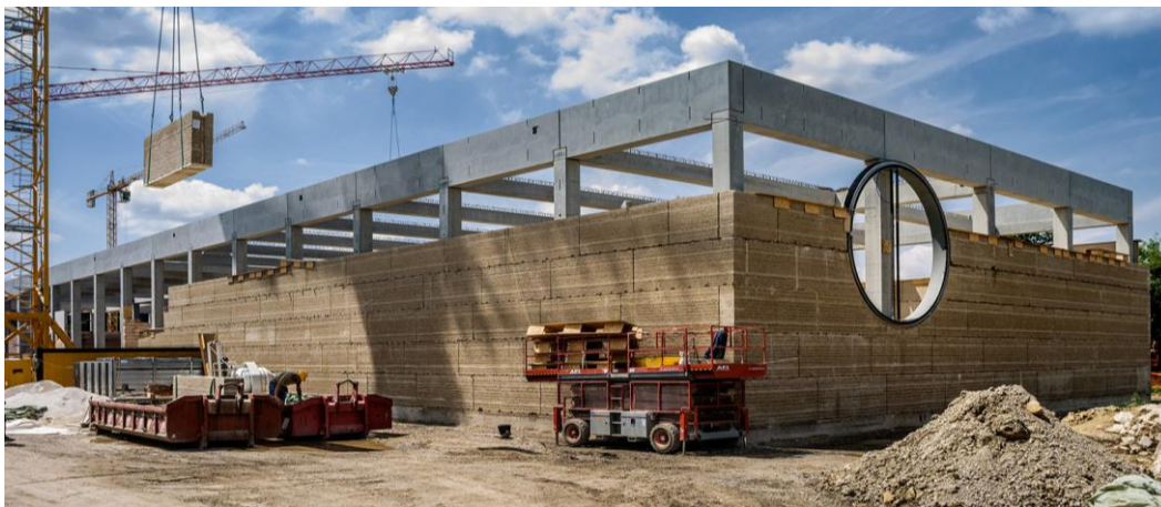
Fig. 235. Imagine din timpul șantierului Ricola Herb Centre, sursă: © Ricola Iwan Baan, https://www.archdaily.com/634724/ricola-krauterzentrum-herzog-and-de-meuron , ultima accesare: 12.2020;
