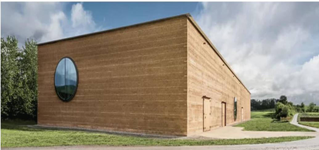
Fig. 234. Centrul Ricola din Elveția, arh. Herzog și de Meuron, constructor Lehm-Ton-Erde, Martin Rauch, sursă: © https://www.architectural-review.com/buildings/earth/ricola-herb-centre-in-switzerland-by-herzog-and-de-meuron-with-martin-rauch , ultima accesare: 12.2020;
