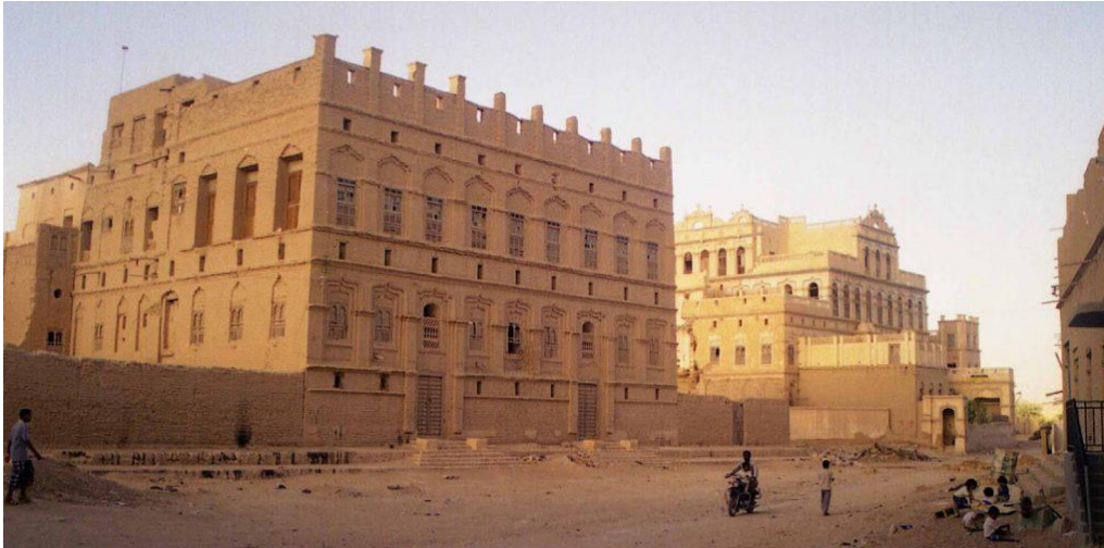
Fig. 137. Perspectivă ilustrând construcțiile din centrul orașului, aflate într-o stare bună de conservare, sursă: © Hiddenarchitecture.net/shiba/, ultima accesare: 03.2021;
