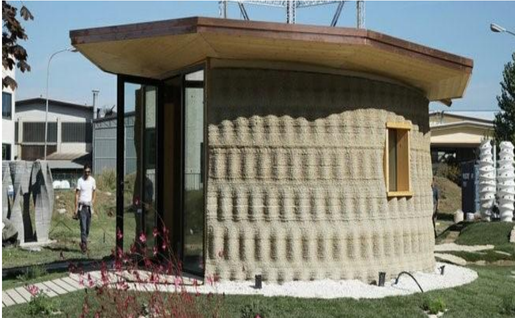
Fig. 73. Fotografie realizată pe șantier, preluare după: © https://www.3dwasp.com/en/3d-printed-house-gaia/ ultima accesare: 01.2021;
