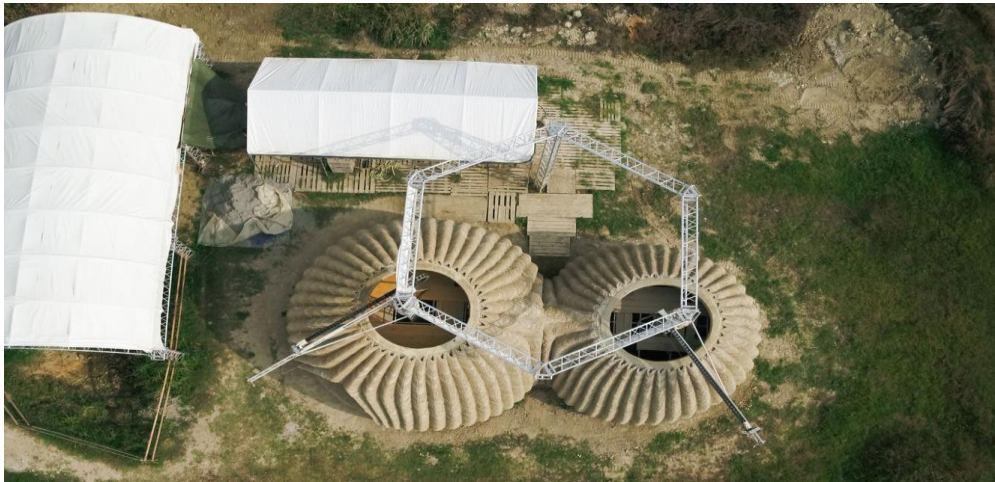
Fig. 78. Perspectivă aeriană ilustrând grid-ul funcțional hexagonal determinat de amplasarea imprimantelor 3D, preluare după: © https://www.3dwasp.com/en/3d-printed-house-tecla/ , ultima accesare: 04.2021;
