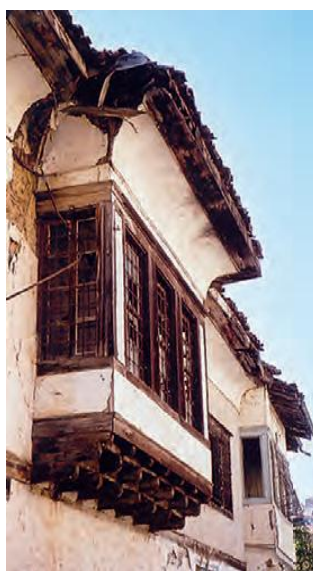
Fig. 12. Locuințe realizate din pereți folosind tehnica pământului compactat, cu bovindou la partea superioară în Agios Lavredios, Pelion, Grecia, sursă: © Georgia Bej, Terra Europae, „Earthen Architecture in the European Union”, ISBN 978-88-467-2957-6, ultima accesare: 03.2021;
