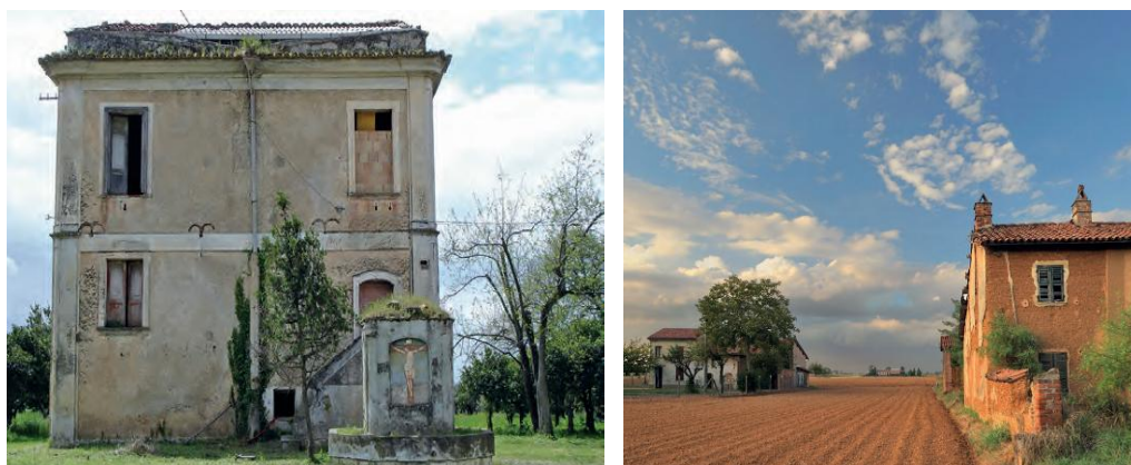
Fig. 16. Locuință din cărămizi nearse în Lamezia, zona Calabria, sursă ©: Ettore Pelaia, Terra Europae, „Earthen Architecture in the European Union”, ISBN 978-88-467-2957-6, ultima accesare: 03.2021;
