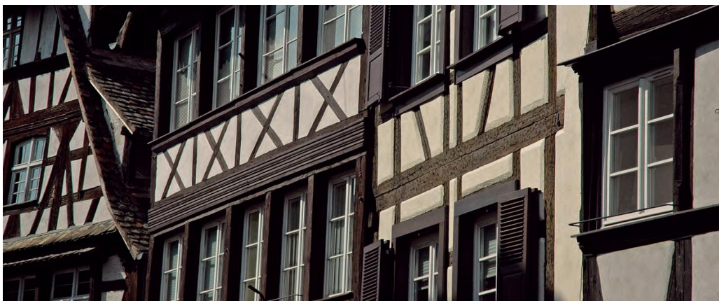
Fig. 25. Construcție din Alsacia, Franța, folosind tehnica colombage, umplută înainte cu paiantă, înlocuită între timp cu cărămizi nearse sau beton celular autoclavizat, sursă: © Terra Incognita. Argumentum/Culture Lab Editions, 2008, Terra Europae, „Earthen Architecture in the European Union”, ISBN 978-88-467-2957-6, ultima accesare: 03.2021;
