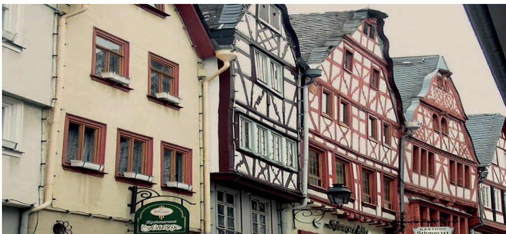
Fig. 26. Locuințe folosind tehnica colombage în Limburg, Germany, sursă: © H. Schreckenbach, Terra Europae, „Earthen Architecture in the European Union”, ISBN 978-88-467-2957-6, ultima accesare: 03.2021;
