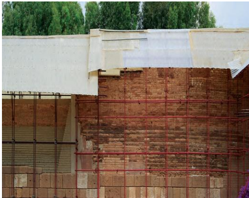
Fig. 6. Restaurarea unui zid fortificat din Gela, Sicilia, Italia, utilizând cărămizi nearse, sursă: © Letizia Dipasquale, Terra Europae, „Earthen Architecture in the European Union”, ISBN 978-88-467-2957-6, ultima accesare: 03.2021;
