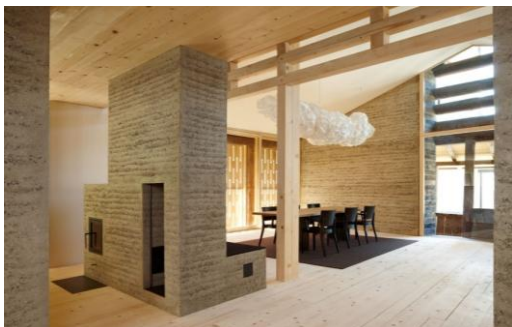
Fig. 69. Pereți realizați prin adaptarea elementelor prefabricate, sursă: © Lehm Ton Erde Baukunst GmbH, ultima accesare: 01.2021;
