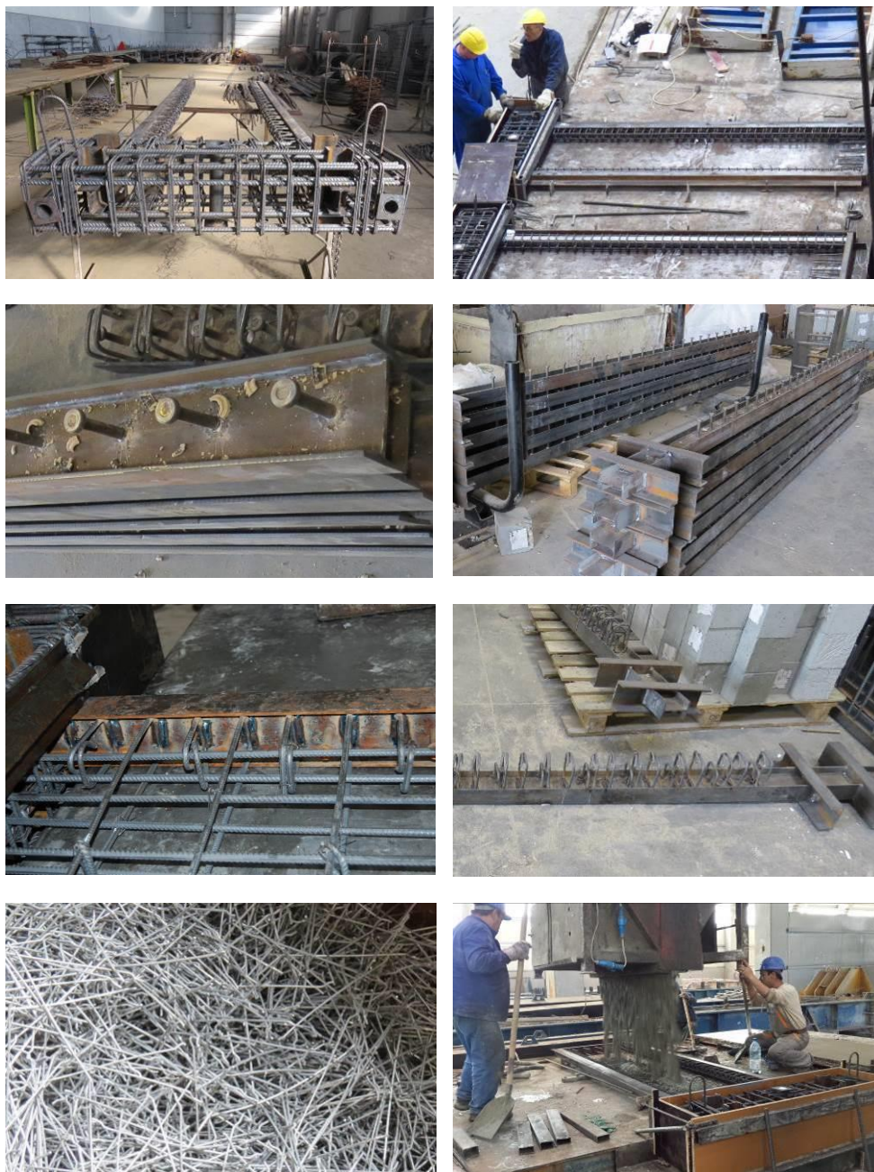
Fig. 4.6 Faze caracteristice din timpul execuției elementelor
