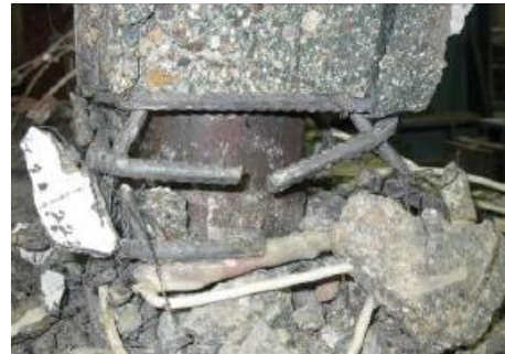
Fig. 2.50 Secțiunea transversală, curbele înfășurătoare respectiv nivelul degradărilor atins la nivelul țevilor metalice [71]
