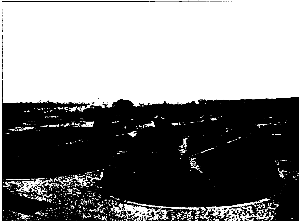
Figura 1.1e „Filtre biologice cu masă filtrantă din cocs și sistem radial de distribuție a apei, Berlin”,
