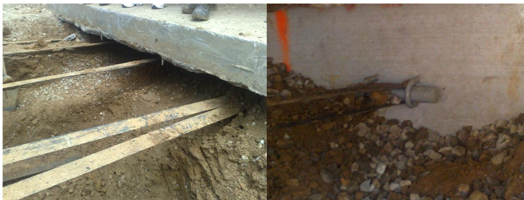
Fig. 6.76. Dezvelire grinda parapet (stânga) și dezvelire prindere armătură (dreapta)
