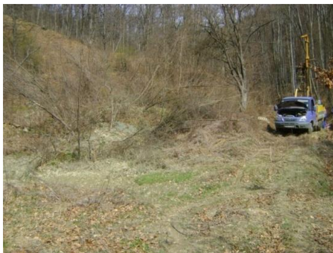
Fig. 6.6. Forajul geotehnic F1
