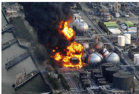
Fig. 2.11. Explozia de la reactorul nr. 2 al centralei nucleare de la Fukushima, Japonia, 2011, avariata de seism și de tsunami
