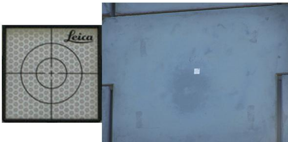
Fig. 6.70. Marca de monitorizare amplasată pe parament
