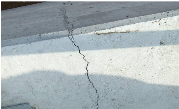
Fig. 6.74. Fisurarea grinzii parapet
