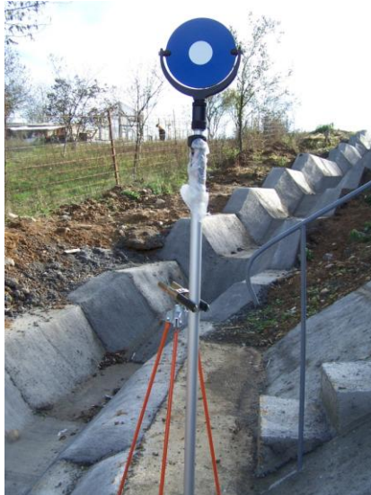
Fig. 6.78. Ținta folosită la scanare în stație pe punctul Con 1
