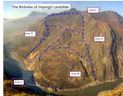
Fig. 5.35. Versantul afectat de alunecarea de teren împărțit pe zone
