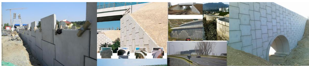
Fig. 6.63. Lucrări executate cu tehnologia de pământ armat
