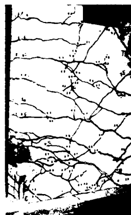
Distribuția fisurilor după cedare (montant mare)
