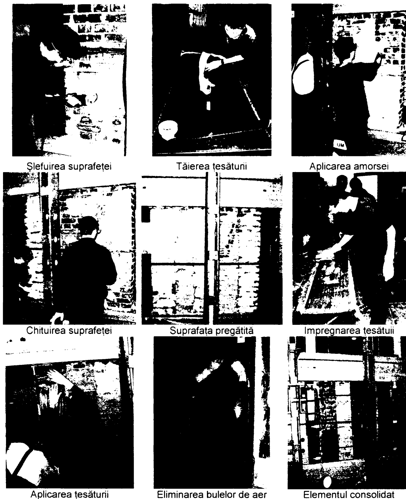
Figura 3.20 - Fazele consolidării
