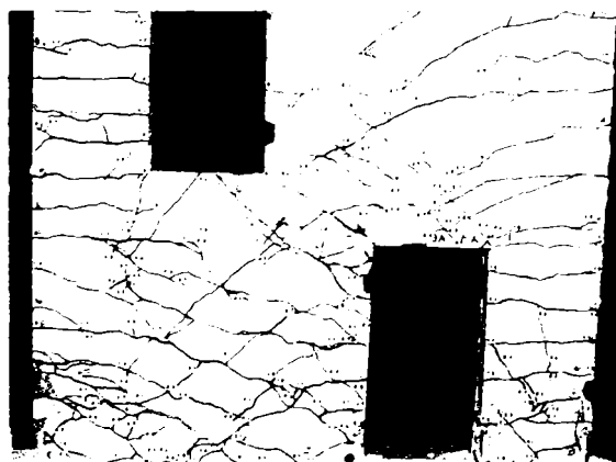
Distribuția fisurilor pe partea inferioară a peretelui după cedare
