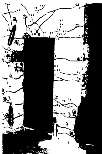
Distribuția fisurilor (montant mic)
