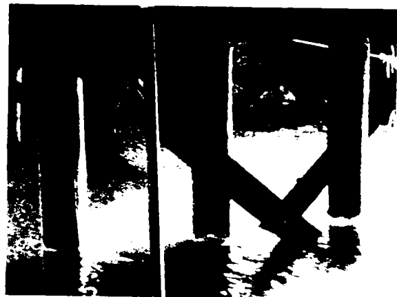
Figura 2.38 - Piloni din lemn consolidați sub apă [P9]
