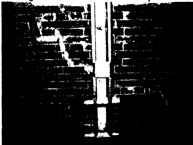
Deschiderea ușoară a fisurii
