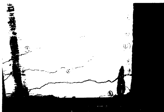
Deschiderea fisurii (vedere față)
