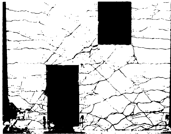
Distribuția fisurilor pe partea inferioară a peretelui după cedare
