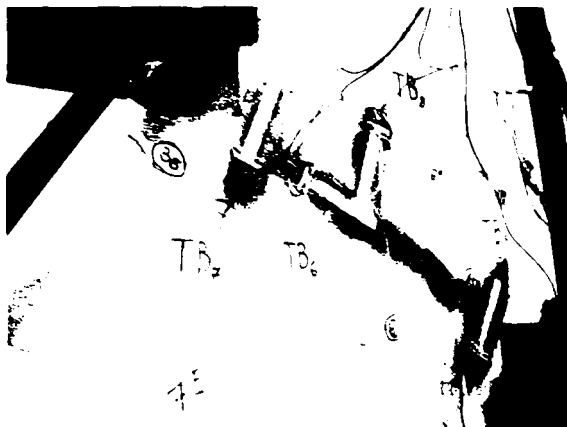
Fisurarea pe diagonală (intre goluri)
