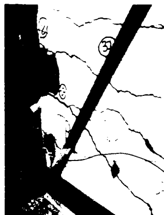
Deschiderea fisurilor (montant mare)
