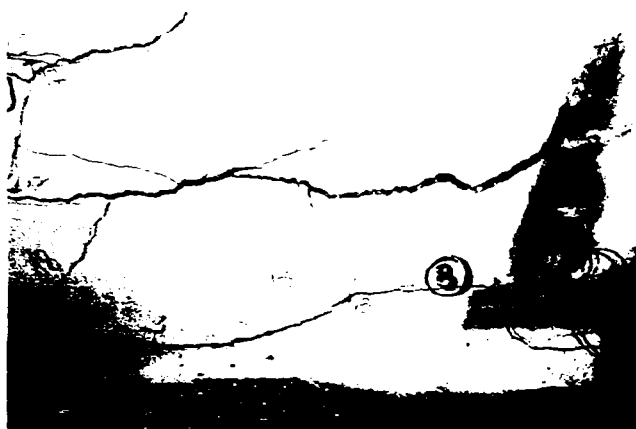
Deschiderea fisurii (vedere față)
