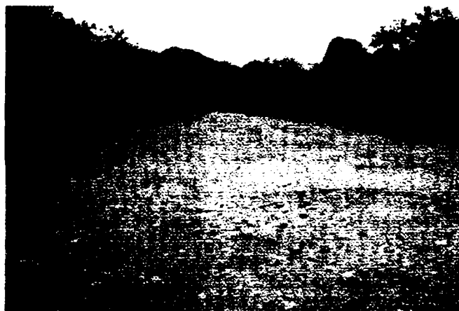
Foto 3.15. Drum pietruit cu balast în amestec cu bolovani de râu.
