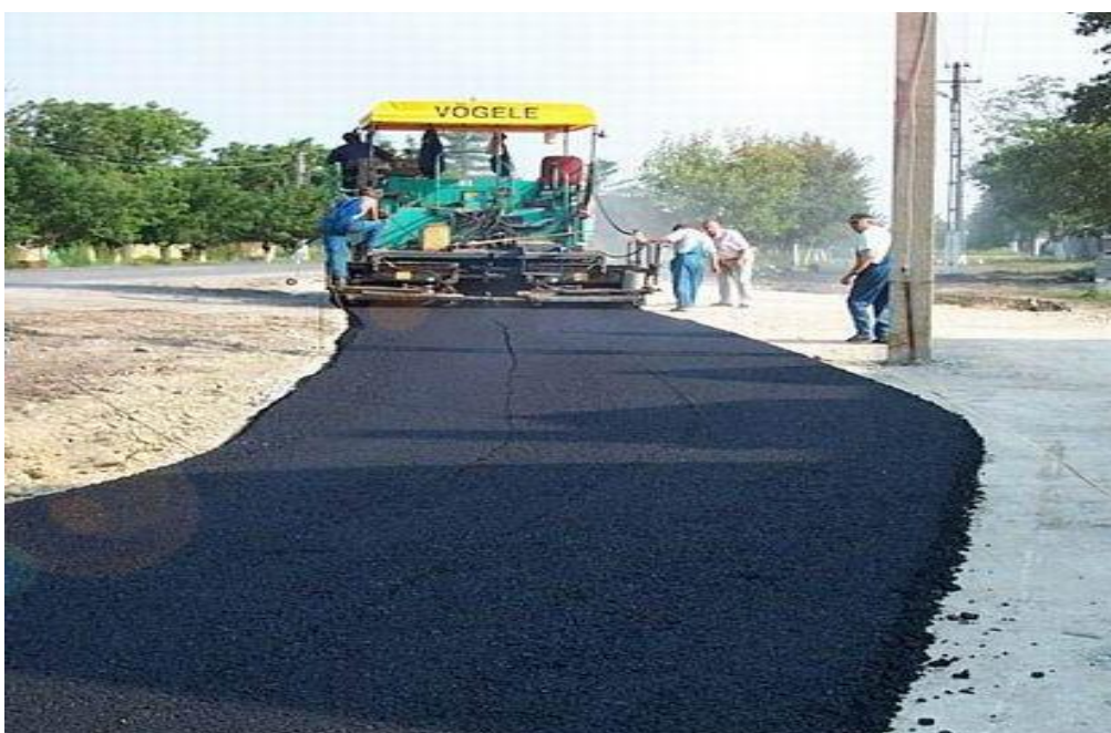
Fig. 4.19. Așternere mixturi asfaltice
