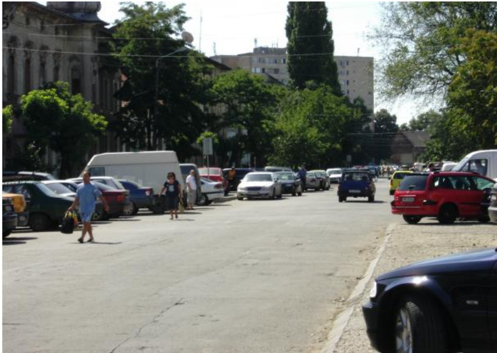
Fig. 4.24. Reabilitarea străzii Iancu Văcărescu
