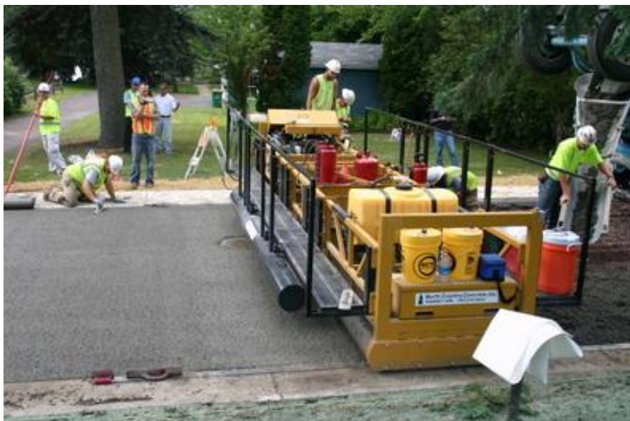
Fig. 4.16. Aplicare îmbrăcămintă din beton de ciment
