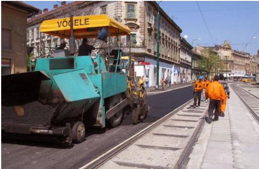
Fig. 4.23. Lucrări de reabilitare a liniilor de tramvai
