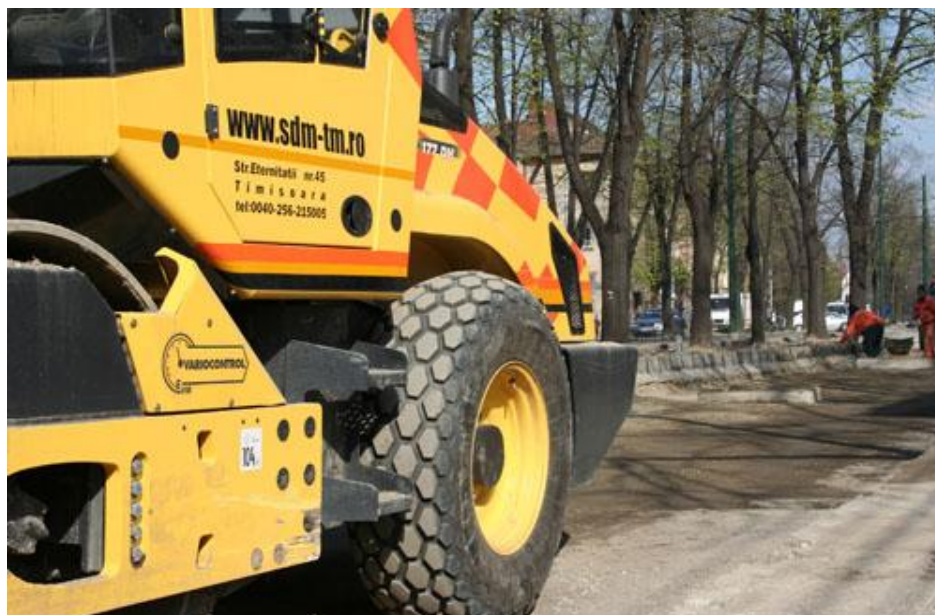
Fig. 4.21. Realizare alei și platforme din pavele prefabricate
