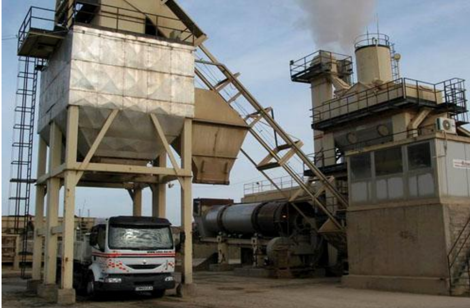
Fig. 4.20. Descărcare mixtură asfaltică în mijlocul de transport
