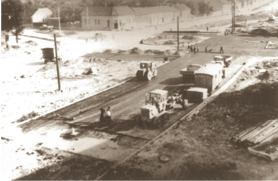
Fig. 4.13. Lucrări de întreținere și reparații la străzi în municipiul Timișoara în perioada 1959 - 1990
