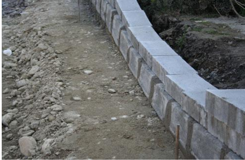
Fig. 4.17. Borduri prefabricate din beton de ciment
