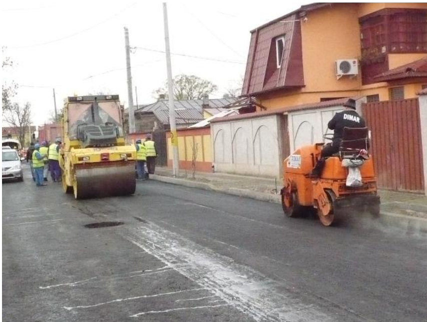
Fig. 4.18. Lucrări de construcții, întreținere și reparații pentru drumuri
