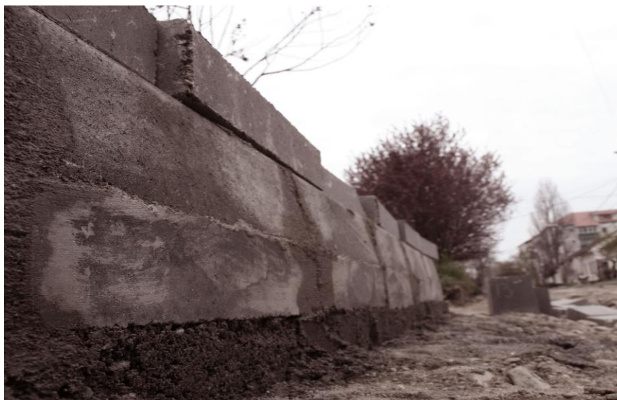
Fig. 4.22. Realizare rețele de apă și canalizare
