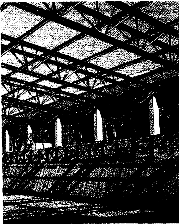
Fig. 4.1.1 Ferme metalice alcatuite din profile cu pereti
