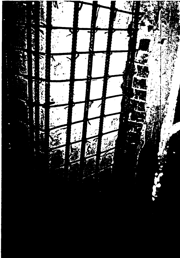
Figura 6.7. Detalii de execuție a consolidării stâlpului SB3.
