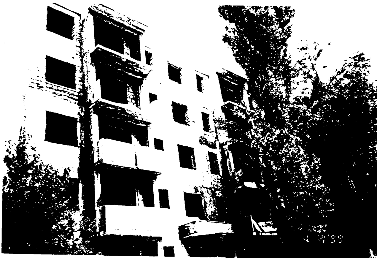
Figura 2.1. Avarieri la construcții (continuare)
