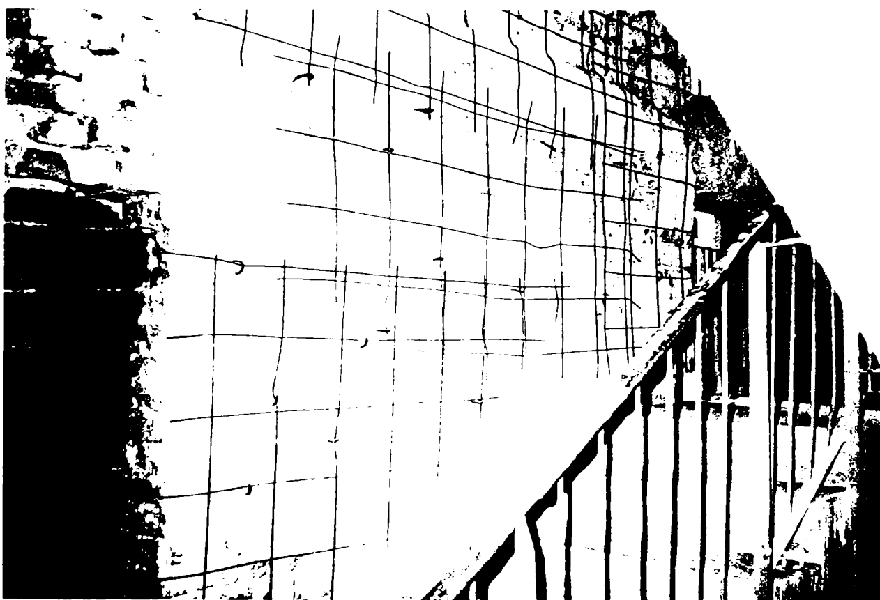
Figura 2.1. Avarieri la construcții (continuare)
