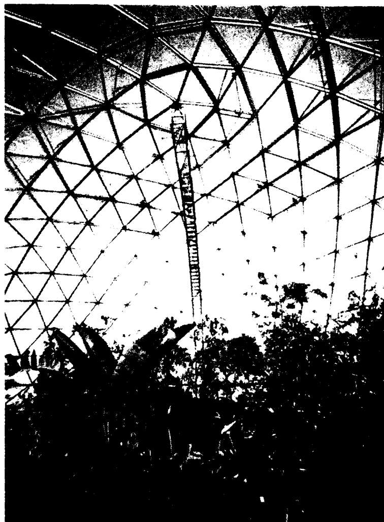
Fig. 1.25 b Vedere din interiorul cupolei Universității din Düsseldorf
