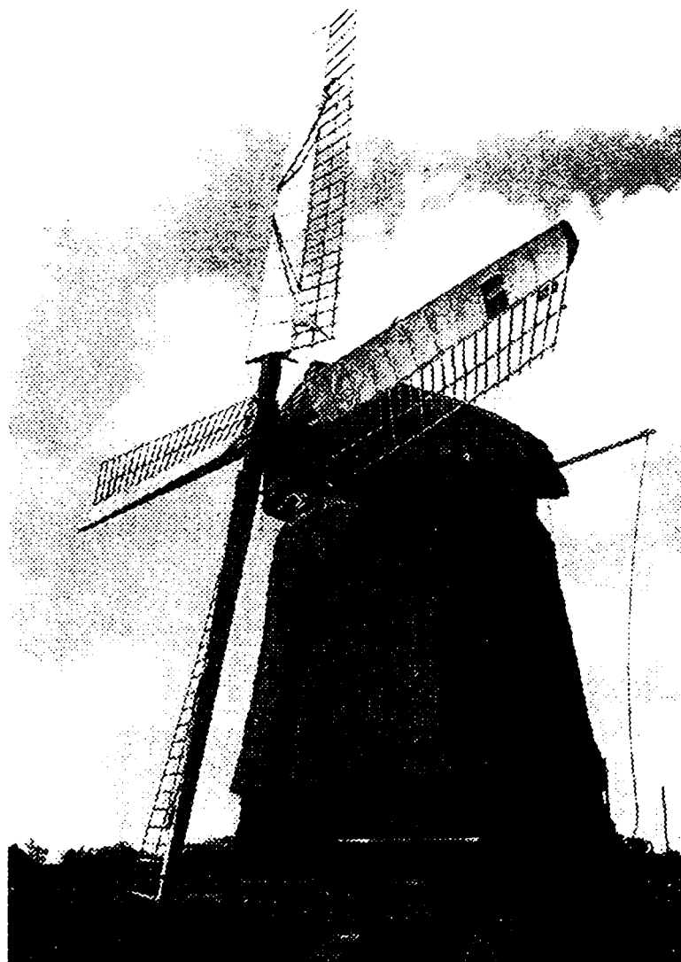
Fig.3.5. Moară de vânt pentru desecări (pompă eoliană) de tipul Nord Olandez construită în 1761, pentru desecarea polderelor Zype și Haze în regiunile nordice
