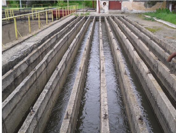
Figura 3.3. Camera de reacție
