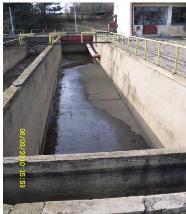
Figura 3.4. Decantor longitudinal
