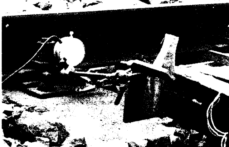
Fig. 2.35 Organizarea măsurării deplasărilor pe verticală ale liniei sub circulație
