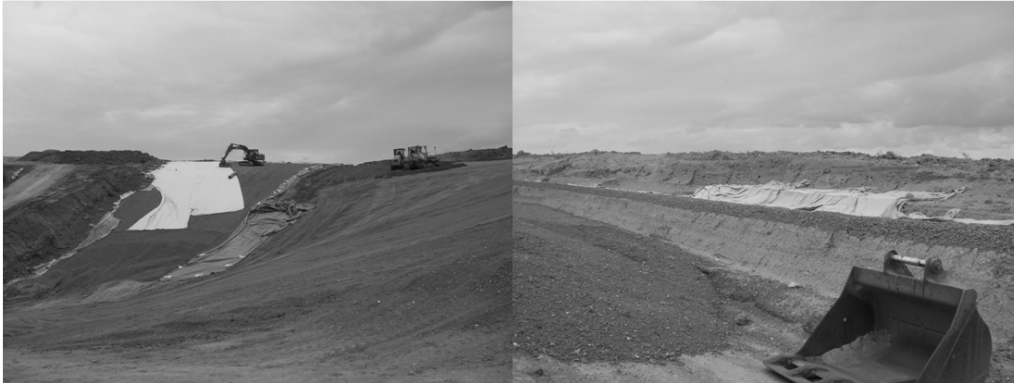
Fig. 3.3 Izolarea suprafeței deponeului (straturile care alcătuiesc izolația)
