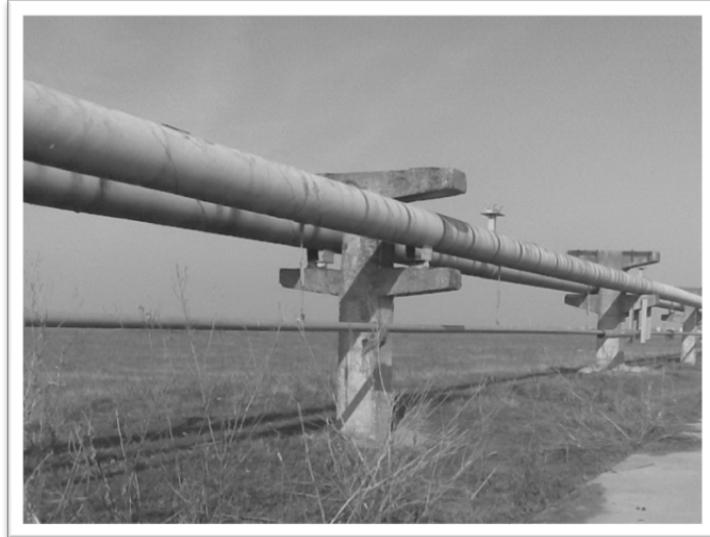
Fig. 3.46 Conducte pentru transportul hidroamestecului
