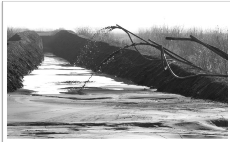
Fig. 3.55 Distribuția șlamului pe depozit
