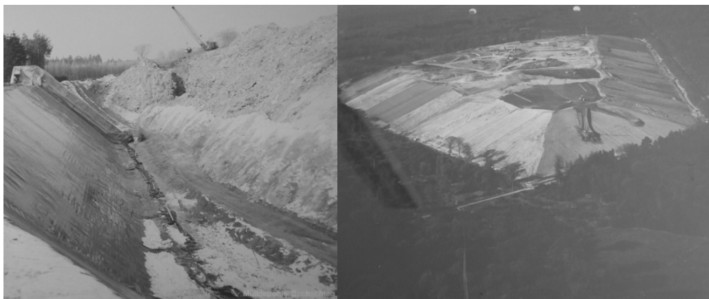
Fig. 3.15 Lucrările de izolare ale deponeului Buchschlag – construirea peretelui izolator și a izolației de suprafață (Agenția de mediu a orașului Frankfurt)
