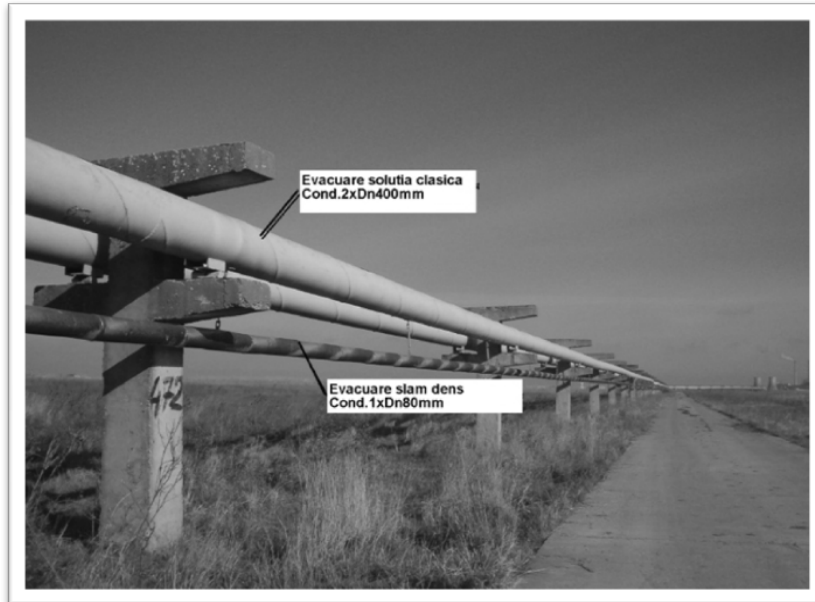
Fig. 3.54 Conductele clasice și cea de șlam dens
