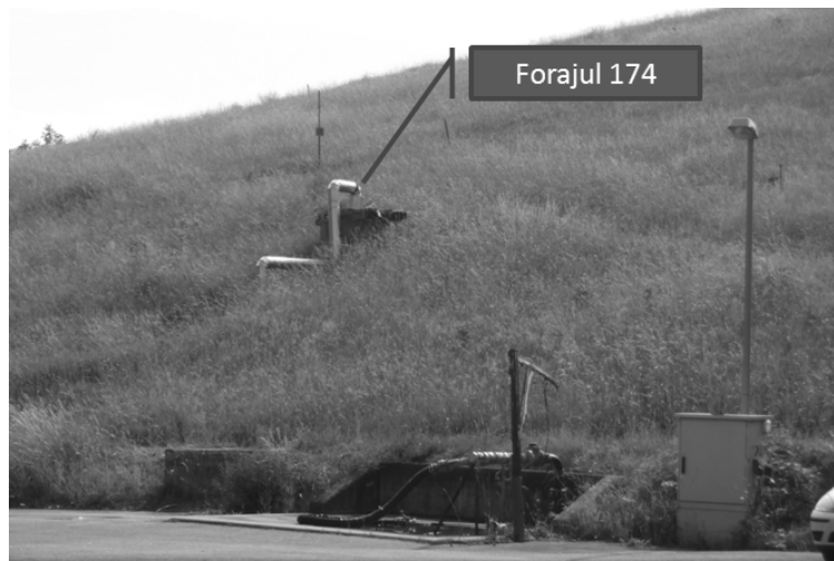
Fig. 3.19 Forajul 174 utilizat ca și fântână pentru extragerea levigatului
