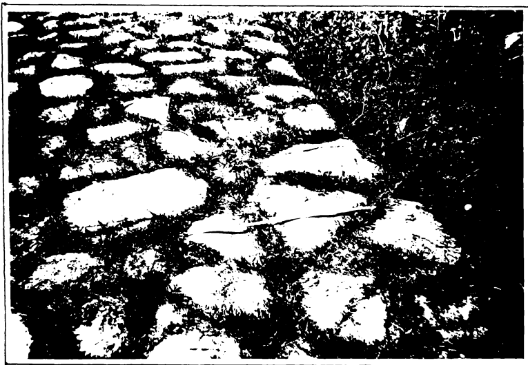
Fig. 1.4. Drumul roman din cetatea dacică Porolissum: stratul de rulare și încadrarea drumului
