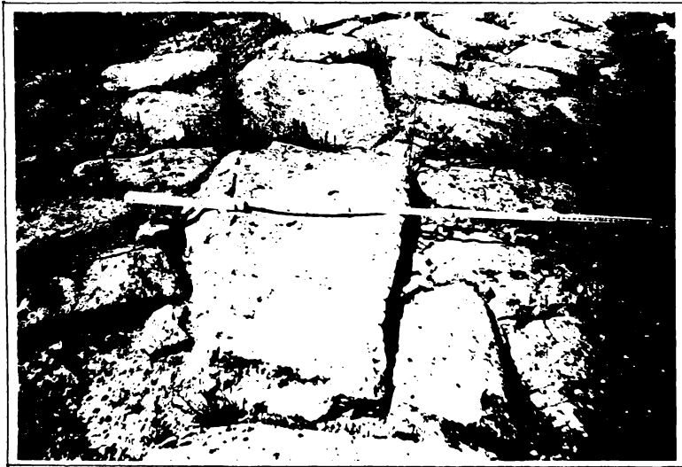
Fig. 1.6. Drumul roman din cetatea dacică Porolissum: suprafața de rulare și axa drumului.
