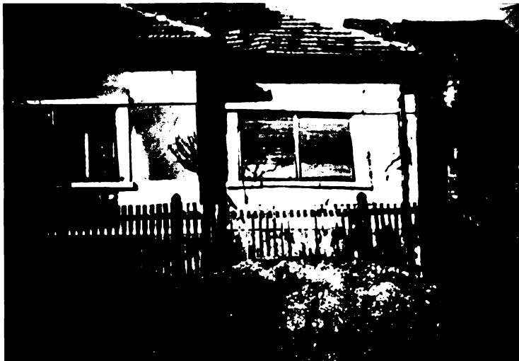
Foto Casa de locuit de la cartierul V. Vlădiciu. Defecte de întreținere necorespunzătoare
