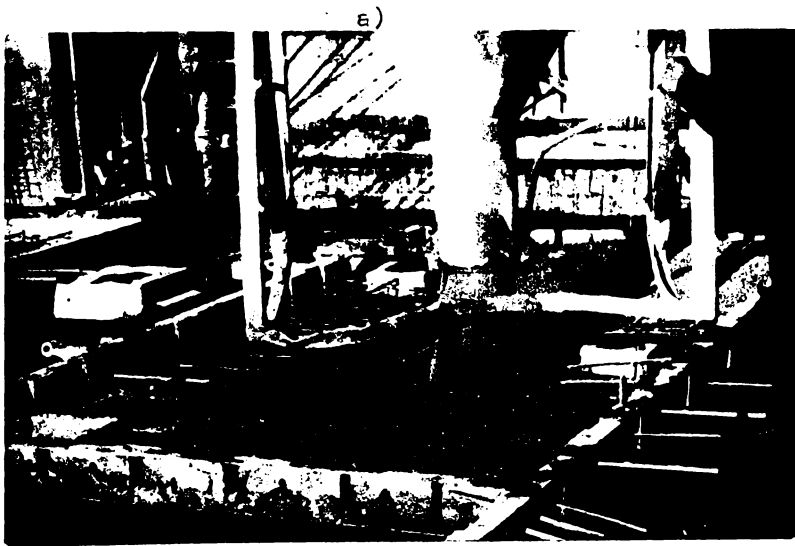
Fig.6.10.a,b. Aspecte de la turnarea unui element de elevație prefabricată T42-16 proiect 1340 IPROTIM, pe standul Antreprizei nr.1 TAGCM Timiș, utilizând beton fluid cu aditiv superplastifiant SP4.
