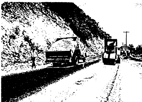
Fig.3.6. Așternerea criblurii 3...8 mm și cilindarea Trabinsitului.
