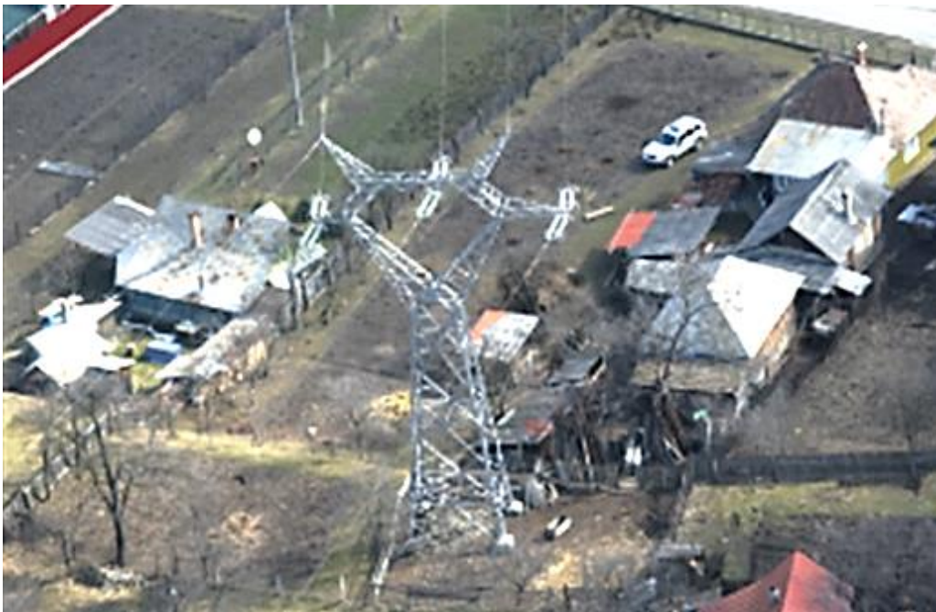
Fig. 3.1.7. LEA 220 kV Stejaru - Gheorghieni, 2008, culoar de trecere, de protecție și de siguranță redus de construcții sub sau în apropierea LEA
