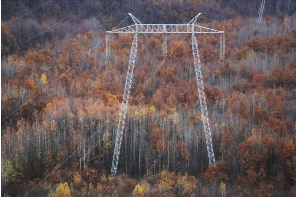
Fig. 3.1.6. LEA 400 kV Urechești - Rovinari, 2008, gabarit redus datorită copacilor sub și în culoarul liniei electrice aeriene
