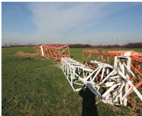
Fig. 3.1.10. 2 (doi) stâlpi metalici de la LEA 400 kV Roșiori – Oradea distruși în 2014 (indisponibilitate LEA 16 zile)
