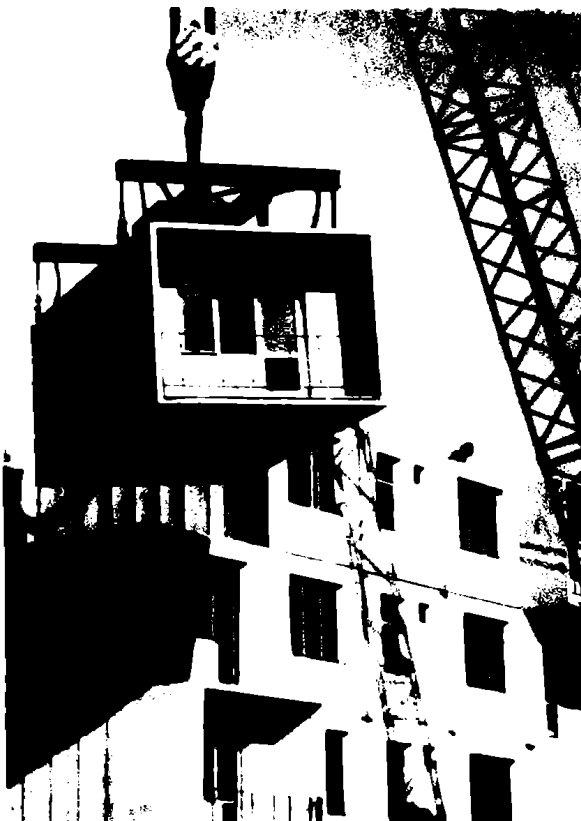
Fig. 2.9 Sistemul ICIM Bv. Fază de montaj.
