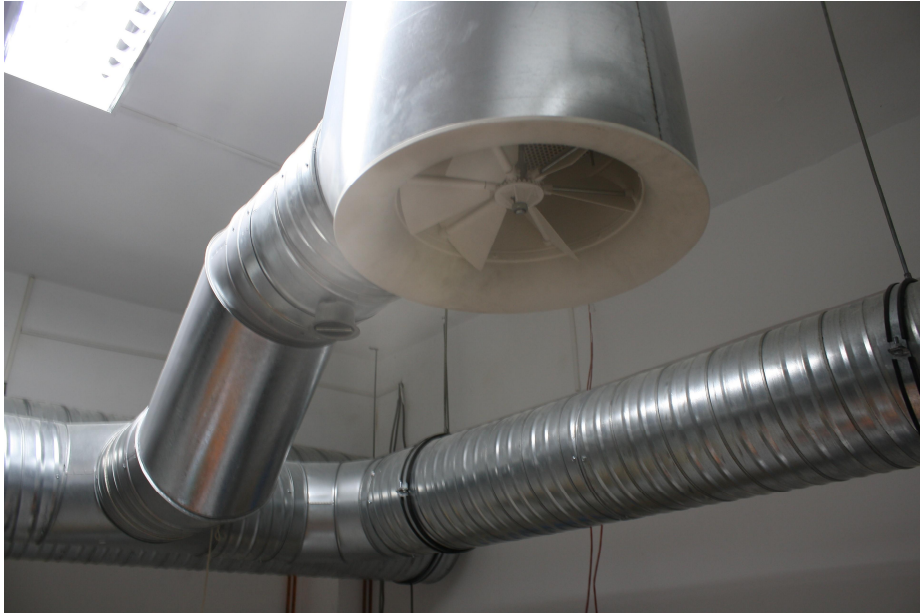
Poză B11 – Gura de introducere cu vârtej vedere laterală
