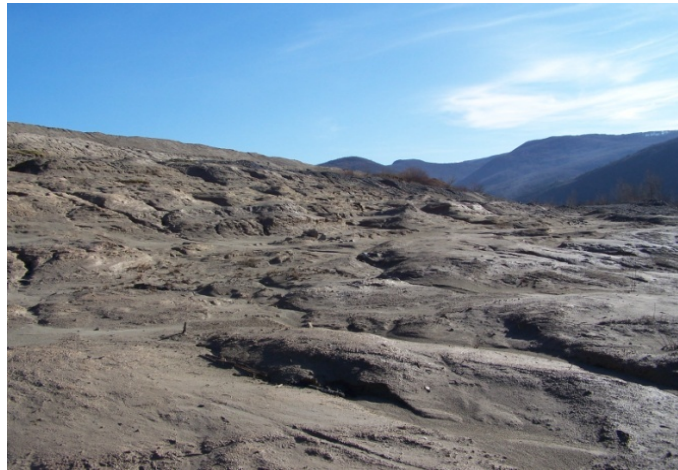
Fig.5.3 Iazul de decantare de la Sasca Montana
