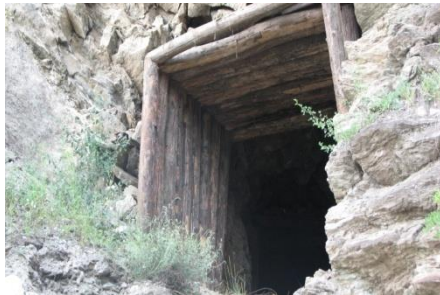
Fig. 4.5 Structură din lemn la o galerie din Teliuc
