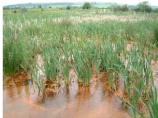
Fig. 5.22 Câmp de filtrare a apei de mină feruginoasă- Marea Britanie Sursa: PIRAMID Design Guidelines 2003
