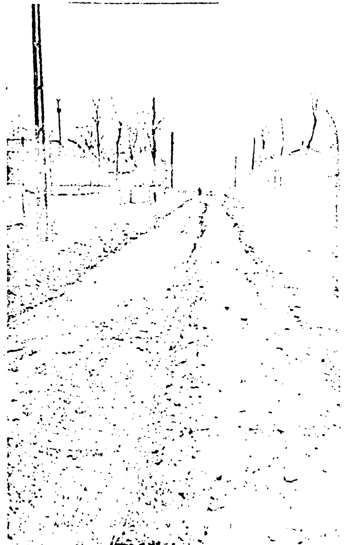
Fig.3.32 - Fâgăse cauzate de trafic intens pe drum tratat chimic, neprotejat.
