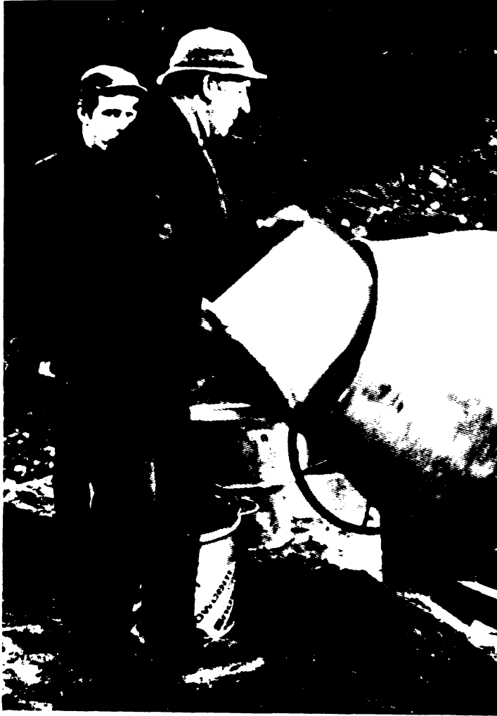
Fig.2.3. Introducerea fibrelor într-un malaxor cu cădere liberă.
