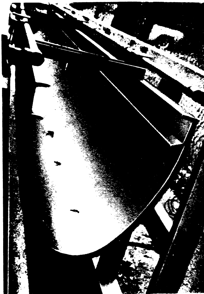
Fig.5.10.b. Indoirea plăcii de oțel, împreună cu betonul proaspăt - faza II-a în tehnologia de fabricare a jgheaburilor.
