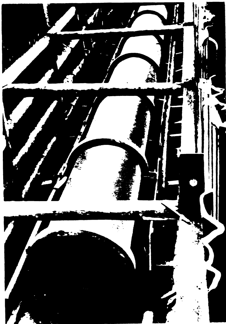
Fig.5.13. Tuburi din beton cu fibre de oțel, de tip "Siome", utilizate în Kőbánya, R.P.U.
