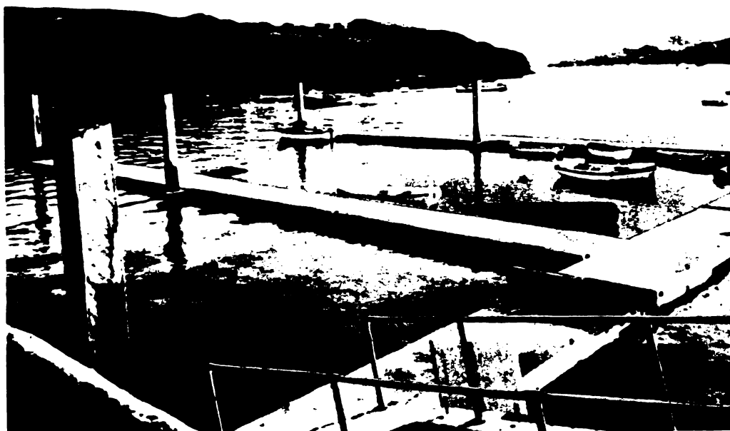
Fig.5.6. Ponton din beton cu fibre de oțel
