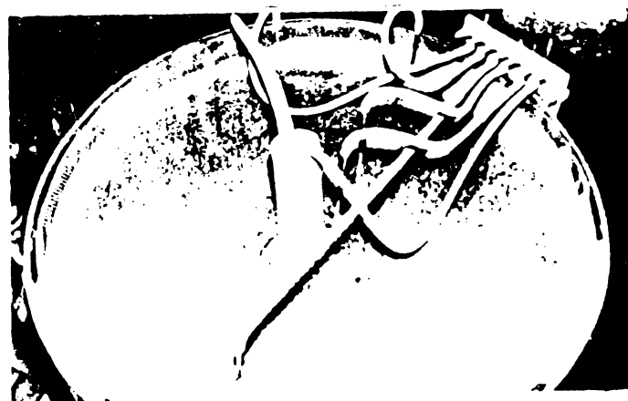
Foto.3. Detaliu varianta cuprinzînd D.P.R. \phi 6,5 cm avînd în jur pietriș sortat (3-7 mm) în grosime de 5 cm ca material filtrant.
