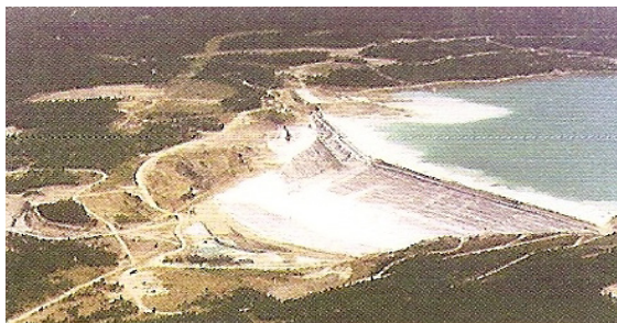
Figura 1.25 Diguri de steril și deșeurii de tratare[ARPMTM]
