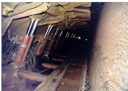
Figura 4.14 Pregătirea stalpilor de abataj [www.cnlo.ro]
