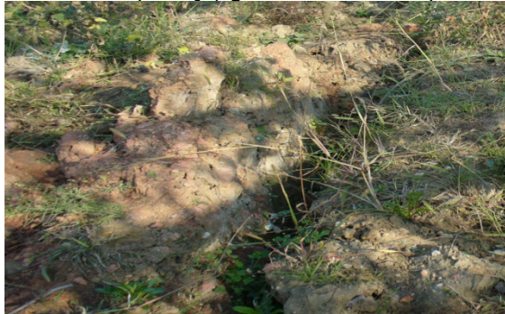
Figura 4.29 Fisură la suprafața solului [Riti A., 2011]
