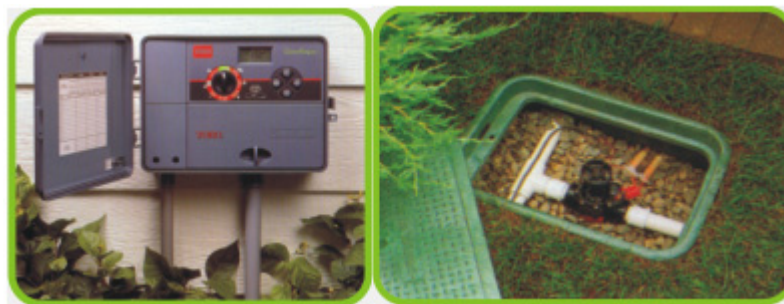
Fig. 5.14 Automatizarea [www.bacons.ro] Fig.5.15 Electrovalve [www.bacons.ro]
