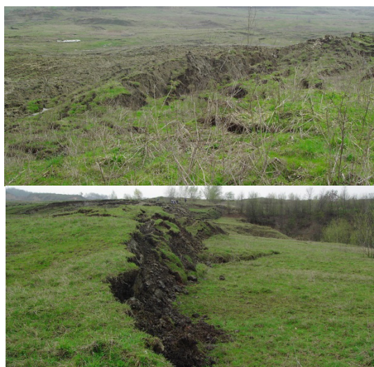
Figura 4.31 Evoluție alunecare de teren Halda Rogoaze
