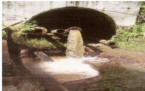
Figura 1.22 Ape evacuate de mina[ARPMTM]
