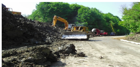
Figura 4.32 Surpare halda Rogoaze peste drumul județean Motru -Târgu -Jiu[EMS MOTRU, 2006]
