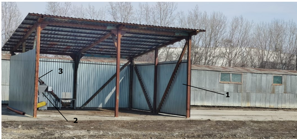
Fig. 3.22. Hala cu echipamentele sale: 1-hala, 2-moara, 3-tub alimentare linie, [arhiva proprie]
