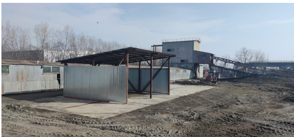
Fig. 3.23. Hala și platforma betonată, [arhiva proprie]
